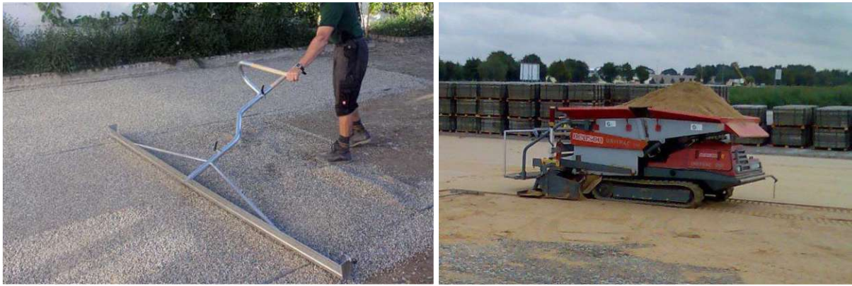
Abb. 2.16: Herstellung einer ungebundenen Bettung händisch li. [32] und maschinell re. [33]
