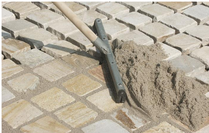
Abb. 2.21: Einbringen des gebundenen Fugenmaterials [39]
