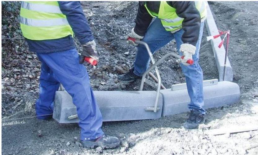
Abb. 2.15: Versetzen einer Randeinfassung [31]
