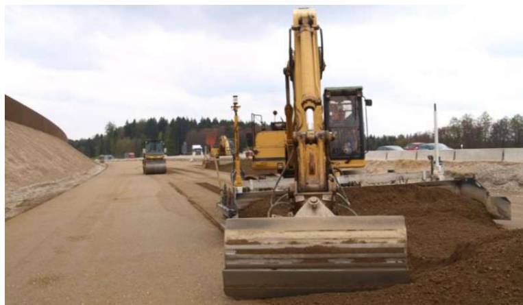
Abb. 2.14: Herstellung einer Tragschicht [30]
