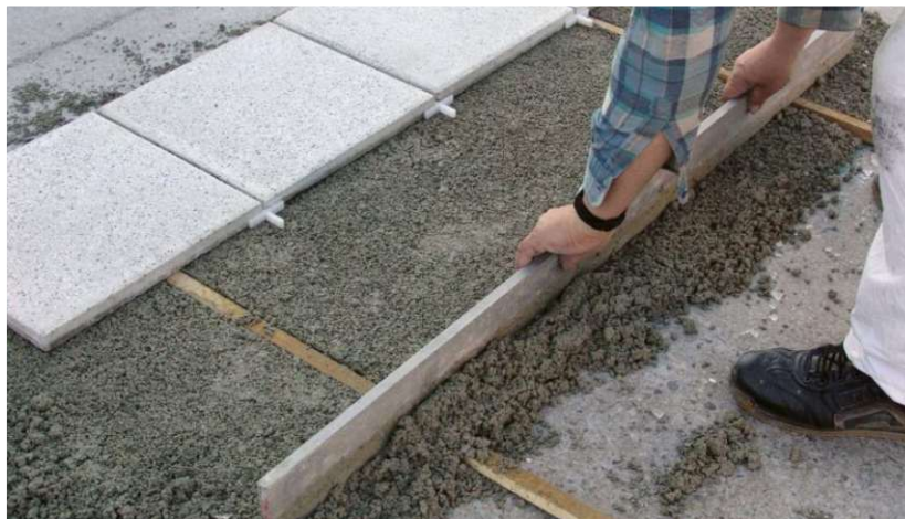
Abb. 2.17: Herstellung einer gebundenen Bettung [34]
