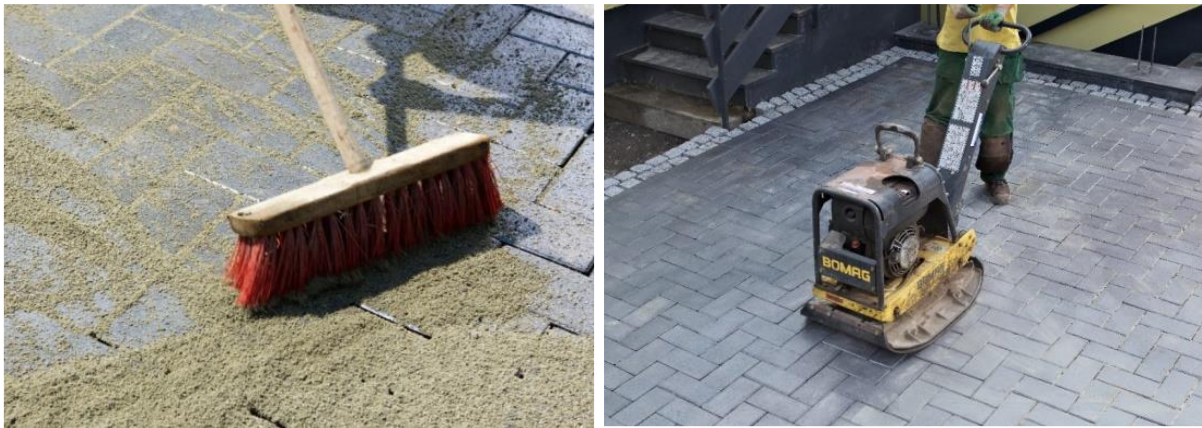
Abb. 2.19: Einbürsten des ungeb. Fugenmaterials li. und Rütteln der Fläche [37]
