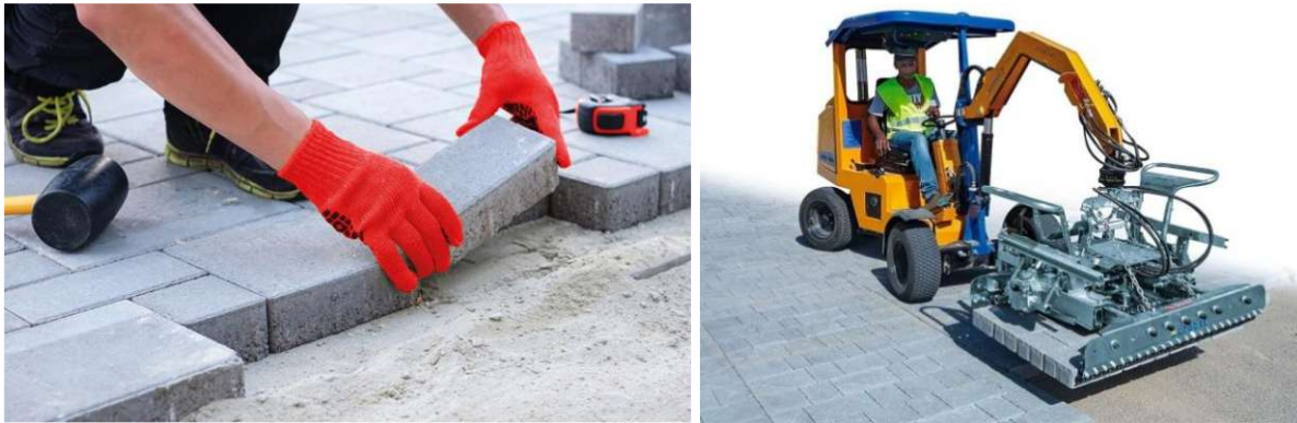
Abb. 2.18: Händische Verlegung maschinelle li. [35] und maschinelle Verlegung mit Verlegemaschine re. [36]
