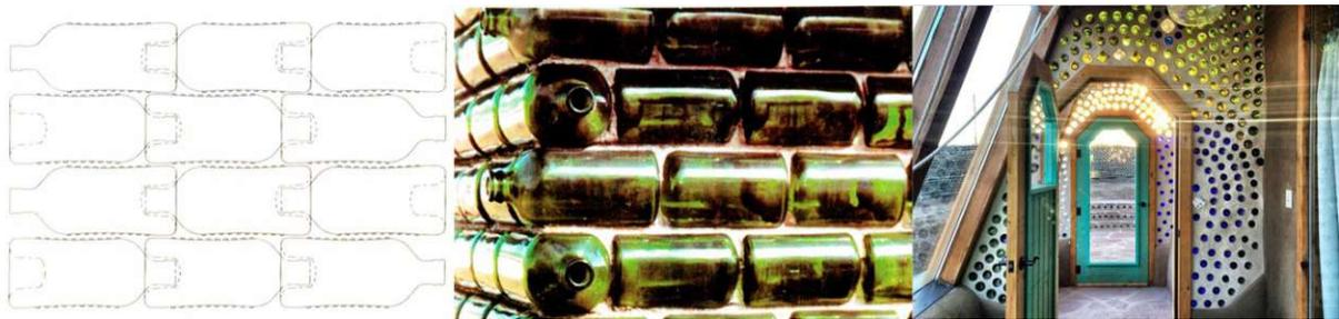
Abbildung 46 Konstruktionsbeispiele mit Glasflaschen [35]
