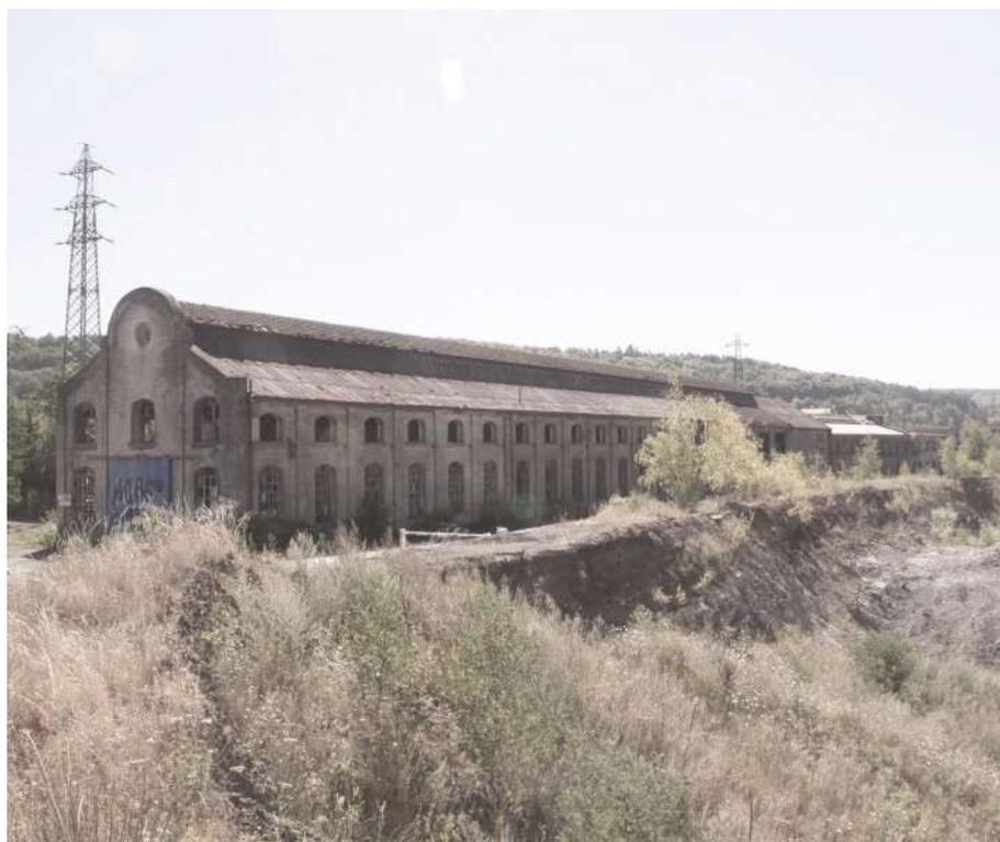
Die ehemalige Zentralwerkstatt des Stahlwerks Terres Rouges stellt einen langgestreckten Baukomplex dar, der sich aus aneinandergereihten stützenfreien Produktionshallen zusammensetzt. Die Errichtung kann grob in drei Bauphasen zwischen 1890 und 1950 unterteilt werden. Die Hallen folgen einer repetitiven Struktur bestehend aus Fensterachsen und Fachwerkträgern unter den Satteldächern.
