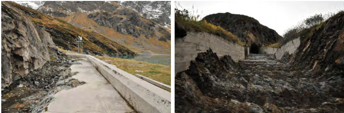
(a) Hochwasserentlastung - Blickrichtung Überfalltrog (b) Hochwasserentlastung - Blickrichtung HW-Entlastungsstollen
