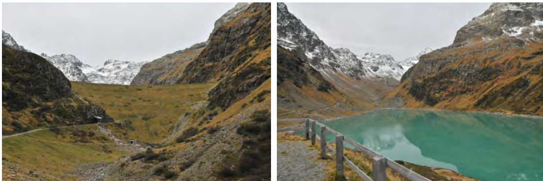
(a) Staudamm Kartell - Ansicht Luftseite (b) Stausee Kartellboden - Blickrichtung Süden
