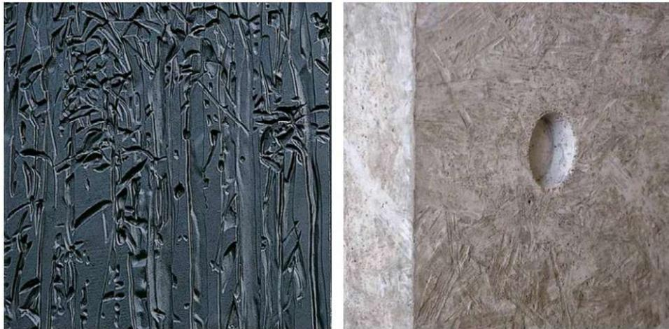
Abbildung 2.6 Betonoberfläche mit Gummi-Matrize texturiert und schwarz gestrichen – Universitätsbibliothek in Utrecht, 2004, Architekt: Weil Arets, Maastricht (links) und OSB-Platten geschaltete Oberfläche mit Kante (rechts) [3]
