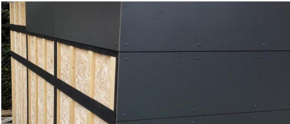
Abbildung 2.40 Montage der HPL-Platte [Quelle: ws-onlineshop.de]
