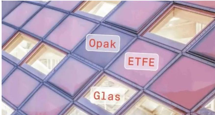
Abbildung 5.3 Verschiedene Fassadenelemente [38]
