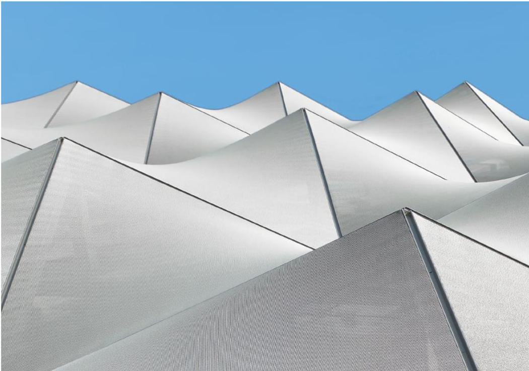
Abbildung 3.1 Flexible Textilfassade [32]
