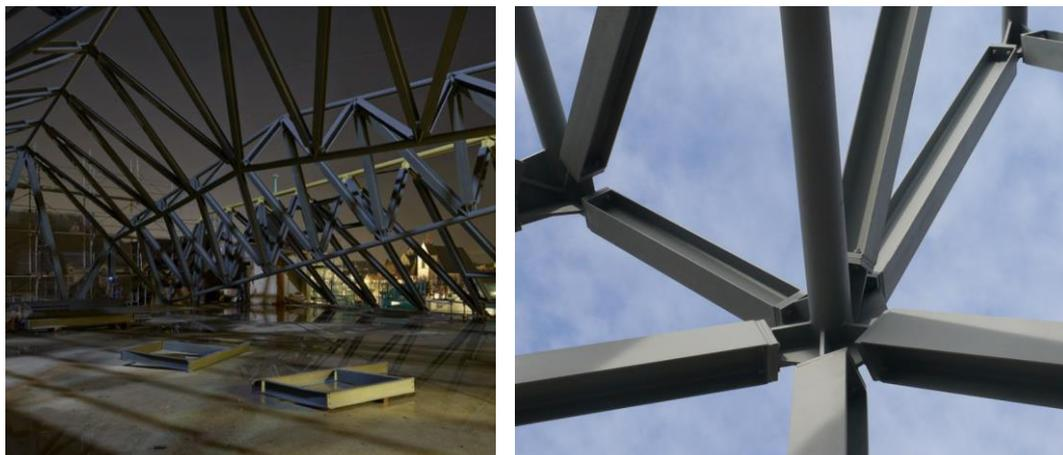
Abbildung 2.29 Raumfachwerk aus Stahl (links) und Anschlussdetails (rechts) [43]
