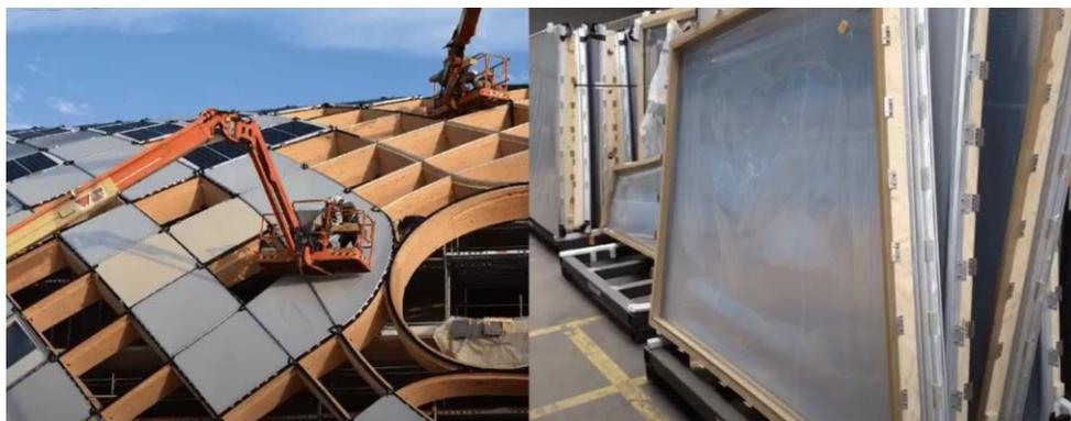
Abbildung 5.2 Hautträger (links) und vormontierte Fassadenelemente (rechts) [38]
