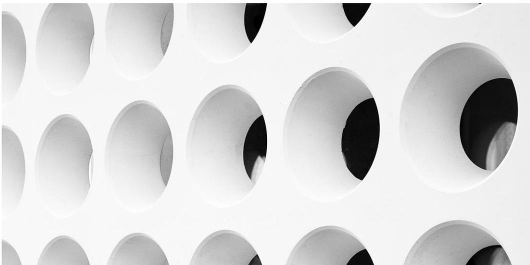
Abbildung 2.15 cast-dreidimensionale Fassade, Wohngebäude Lontoonkatu, Helsinki, Finnland [9]
