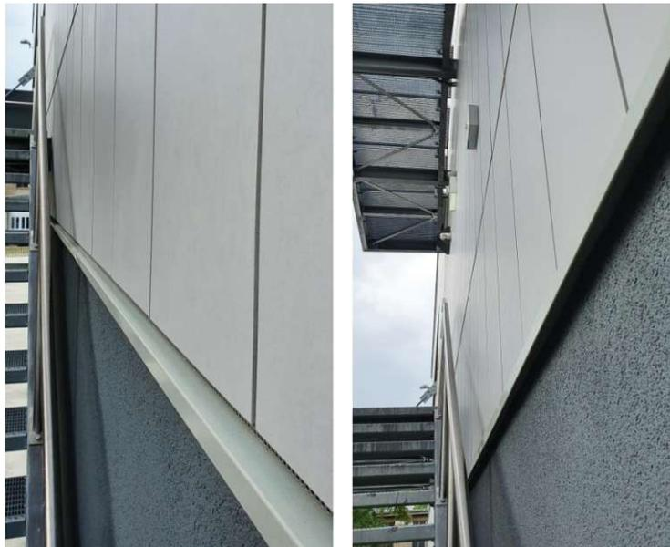
Abbildung 2.21 Faserzementtafeln am Objekt OD, TU Wien
