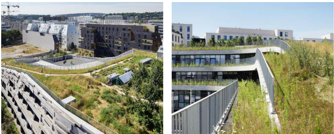
Figure 13 École des Sciences et de la Biodiversité, roof gardening and terraces
