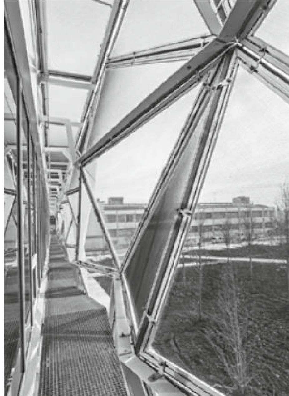
Abb. 42: Unterkonstruktion der Fassade, Quelle: facade-textile-international
