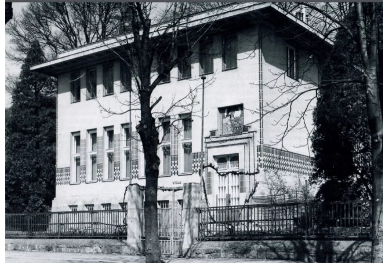
Abb. 3.2-7.: Villa Wagner II in Wien Hütteldorf 1912
