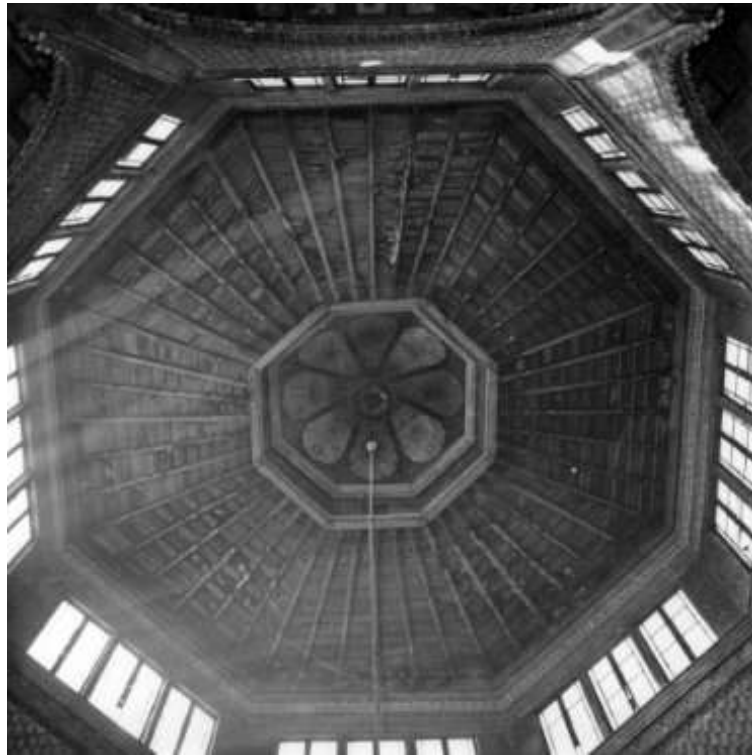
Abb. 4.3-34.: Oberer Raumabschluss, Fotografie 1971
