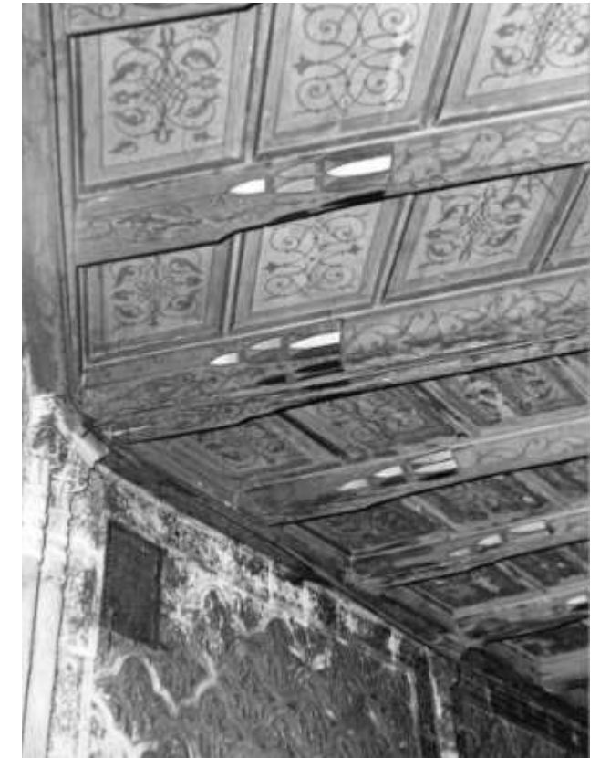
Abb. 3.4-17.: Holzbalkendecke Erdgeschoß, Fotografie
