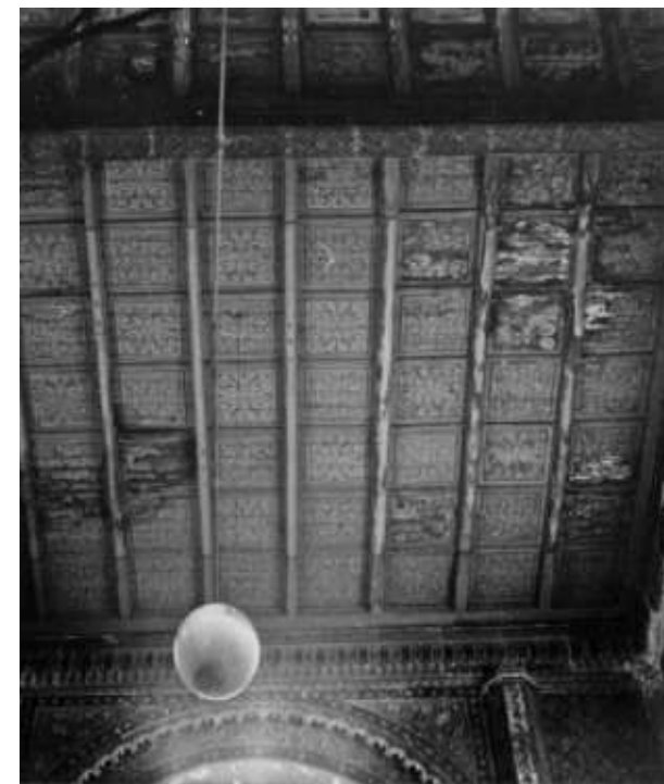
Abb. 3.4-16.: Holzbalkendecke erweiterter Ostraum, Fotografie 1874
