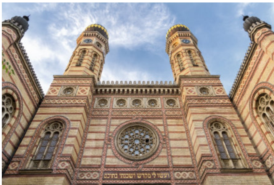
Abb. 3.5-3.: Fassade Große Synagoge Budapest
