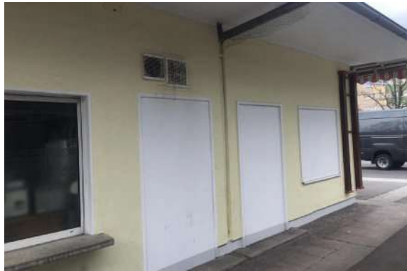
Marktkoje nachträglich zugemauert
