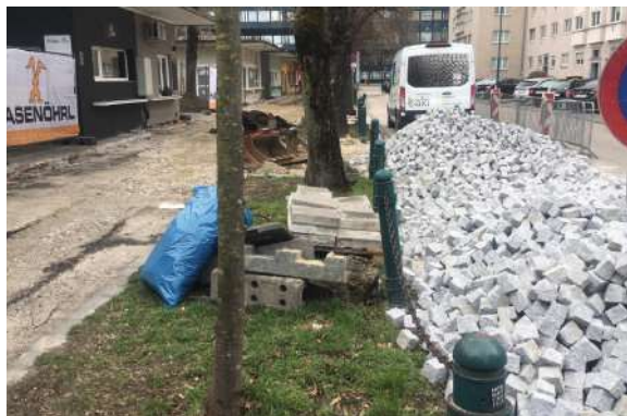
Sanierung der Bodenoberfläche
