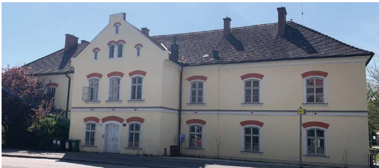
Bahnkanzleigebäude Eingang über die Ostfassade
