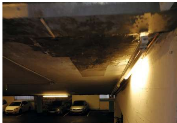
Beleuchtung der Tiefgarage
