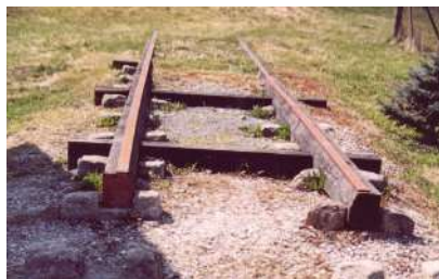
Abb.7 Teilweise (atypisch) rekonstruierter Oberbau der Pferdeisenbahntrasse Budweis - Linz
