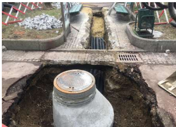
Erneuerung der Kanalisation
