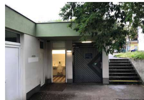
WC-Anlage im Osten des Areal
