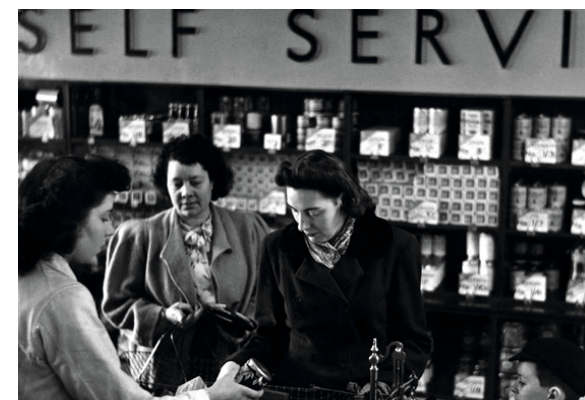
Abb. 27 1930 wurde der erste Supermarkt in einer ehemaligen Autowerkstatt in New York von der King-Kullen-Kette eröffnet.
