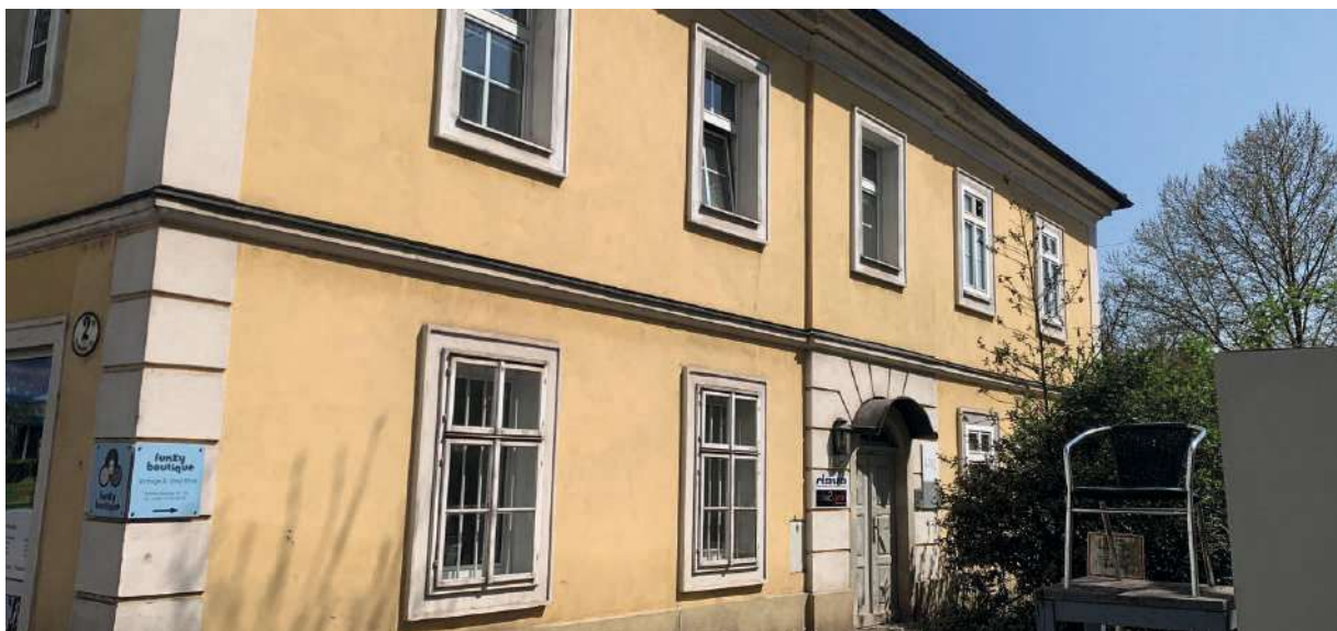
Verwaltungsgebäude Eingang über die Westfassade
