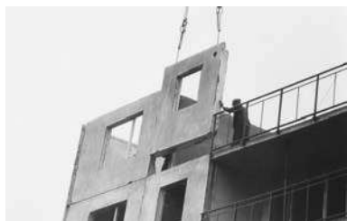
Abb. 172 Baustellenbild, Versetzen der Fertigteile
