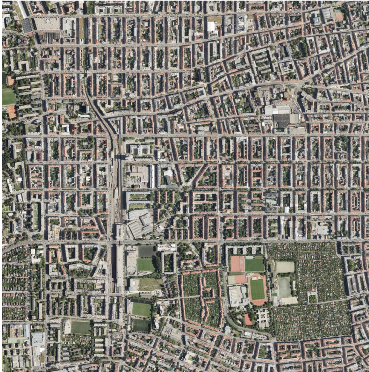
Abb. 14 Luftbild Wien, Bereich um Guttraterplatz im 16. Bezirk
