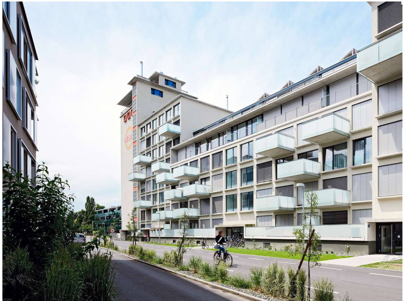
Abb. 51 Außenaufnahme der sanierten Fassade der ehemaligen Kraftfutterfabrik im Velag Areal in Bregenz.
