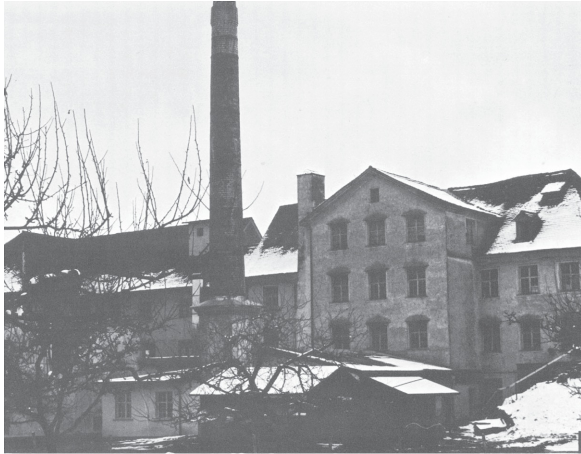
Abb. 17 Aufnahme der Hauptfassade der Spinnerei Juchan in Dornbirn.
