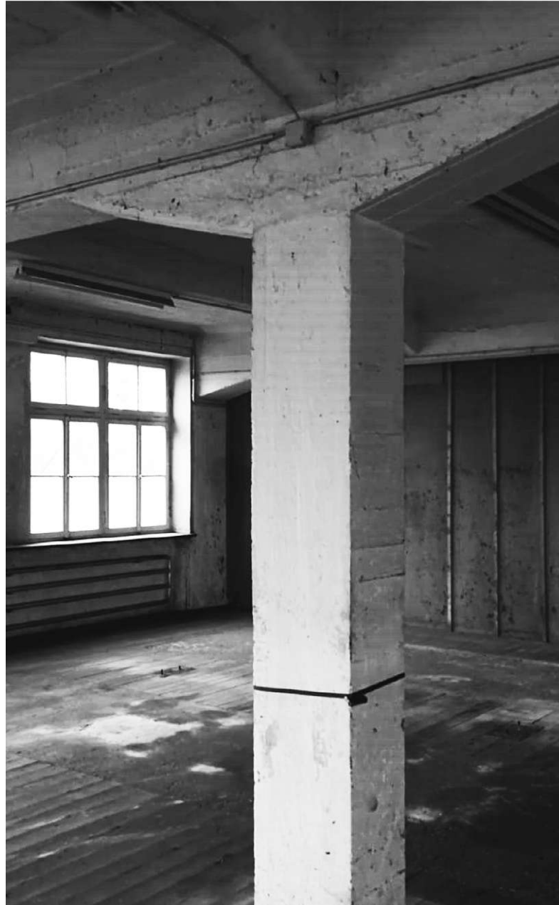
Abb. 92 Stütze im Erdgeschoß der Klöppelei Alexander Hesse in Wolfurt 2018.
