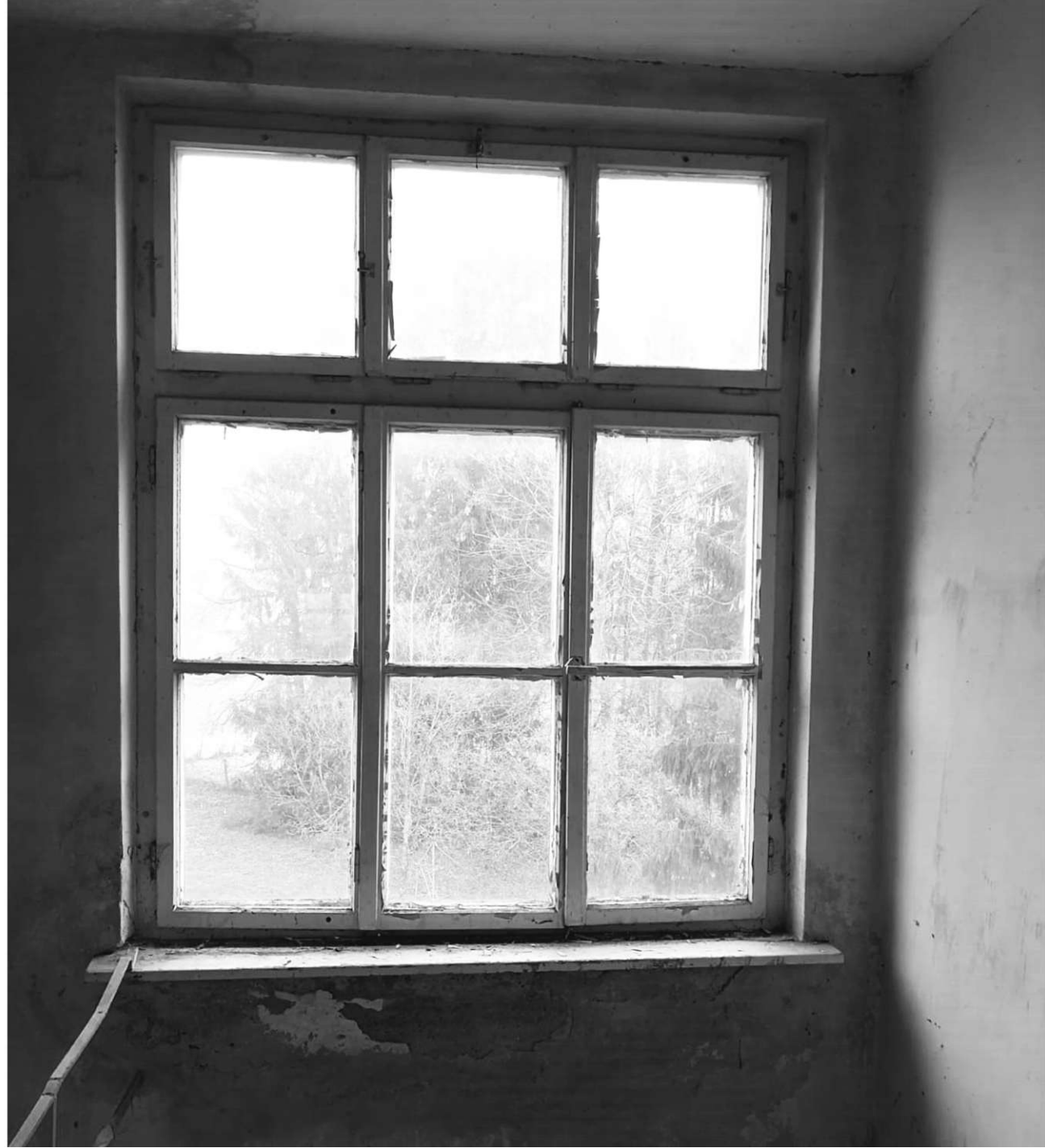
Abb. 97 Fenster im Treppenhaus der Klöppelei Alexander Hesse in Wolfurt 2018.
