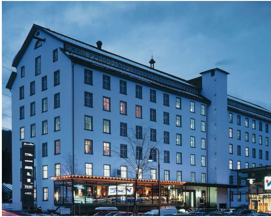
Abb. 34 Außenaufnahme der Fassade der sanierten Lünzerseefabrik in Bürs.
