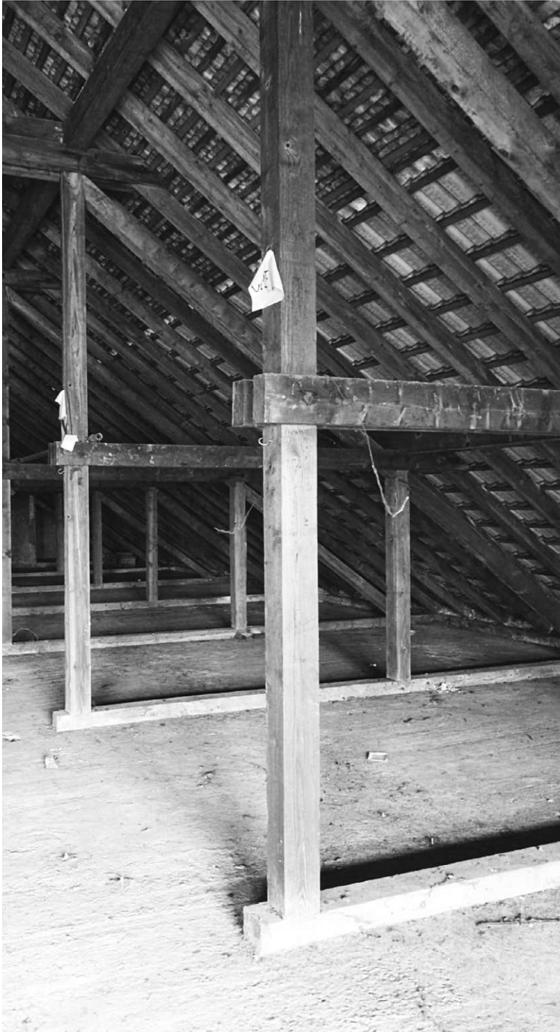
Abb. 99 Dachstuhl im Dachgeschoß der Klöppelei Alexander Hesse in Wolfurt 2018.
