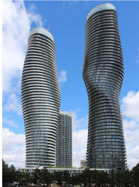
Die Absolute Towers oder auch Marilyn Monroe Towers genannt, wurden von MAD Architects entworfen und befindet sich in der kanadischen Stadt Mississauga. Sie haben eine Höhe von 161m und 179m und sind aus Stahlbeton konzipiert. Die hohen Windlasten werden durch die aerodynamische Form der Türme ausgeglichen.
