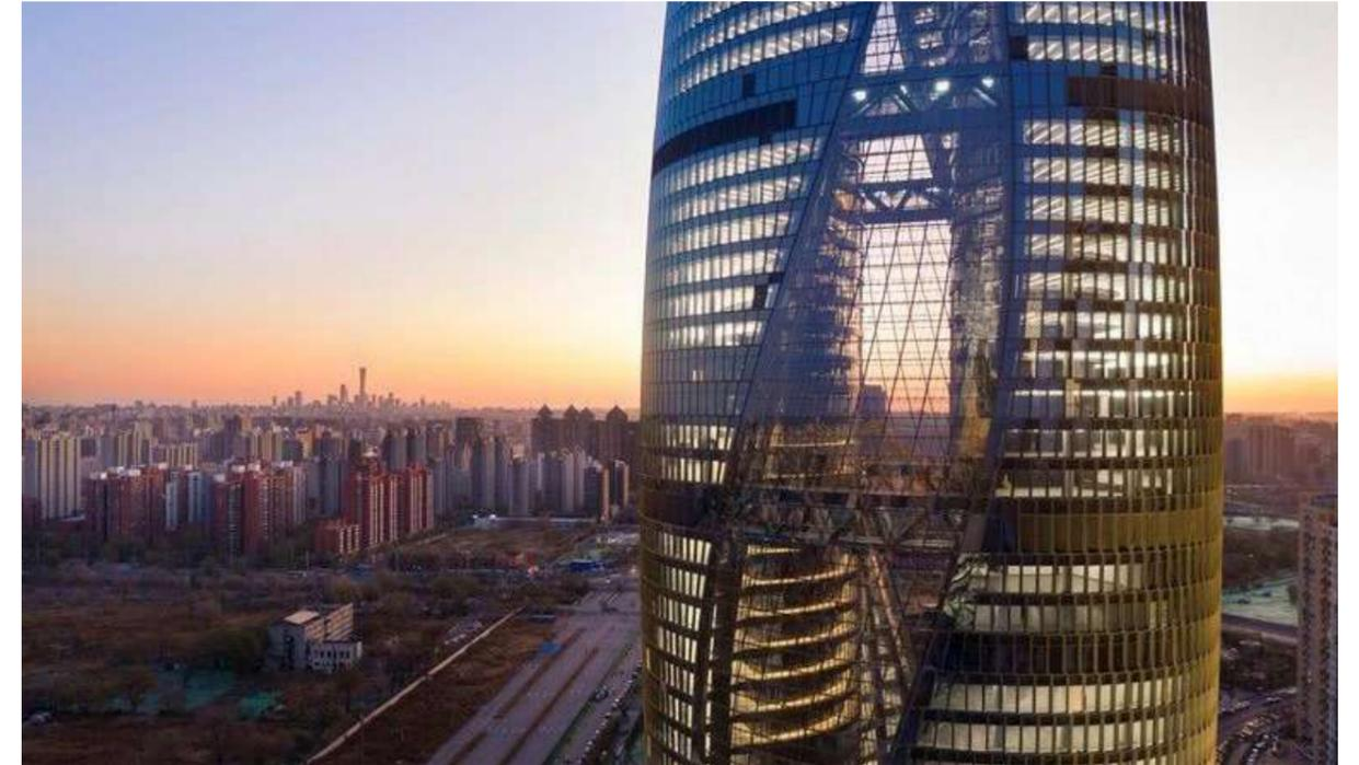
de verläuft hat einen beträchtlichen Einfluss auf den Entwurf und das Design des Büroturms genommen. Die Konstruktion dieses Gebäudes ist sehr komplex. Sie besteht aus zwei zentralen und getrennten Stahlbetonkernen und einem Skelettbau an der Fassade. Die an der Fassade gelegenen Rundstahlprofile werden mit Beton befüllt. Die horizontale Last wird durch Stahlunterzüge zu
