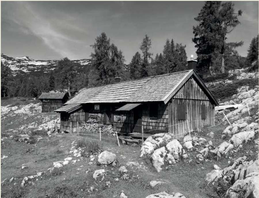
Abb.52: Typische senkrechte Bretterschalung (li) und Bretter-Leistenschalung (re). Abb.53: Almhütte mit Bretter-Leisten- und Holzschindelschalung, Wildenseehütte, erbaut 1922 durch Österreichischer Alpenverein, Sektion Ausseerland, Fotografie 2019.
