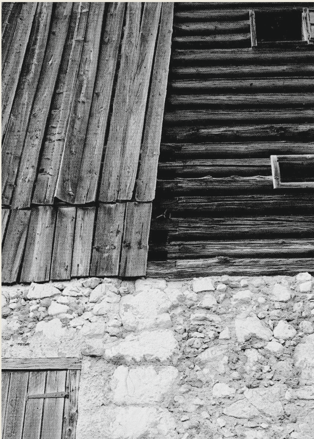
Abb.54: Peter Grill: Beispiel für ein Bruchsteinmauerwerk als Sockel und einem oberen Aufbau in Blockbauweise und senkrechter Bretterschalung, Fotografie, 2015.
