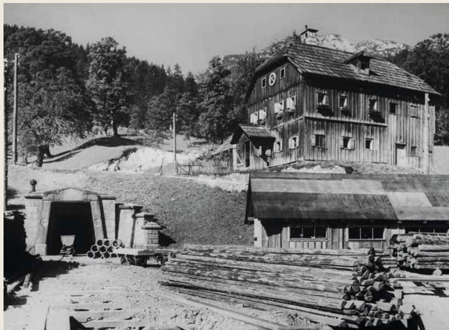
Abb.23: Salzberg: Ausmündung eines Unterfahrungsstollens mit Werkstätte und Scheibenhaus. © Bildarchiv Austria
