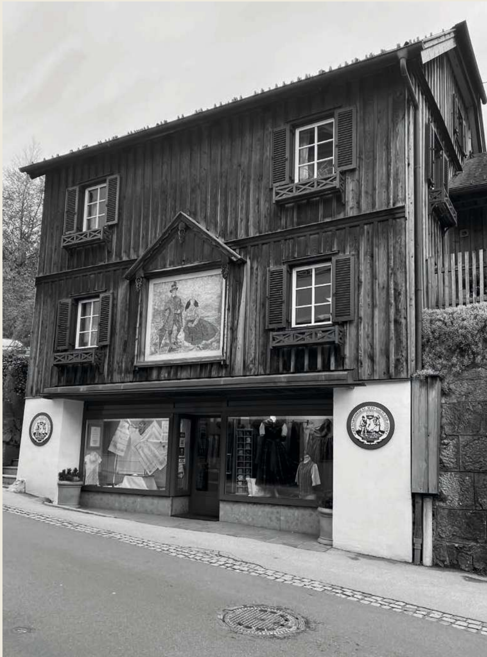
Abb.144: Typische Fassadengestaltung eines Ausseer Hauses. Auch hier wurde auf die klassische Schalung zurück gegriffen. Haus in der Bahnhofstraße 108, Bad Aussee, Fotografie, 2020.
