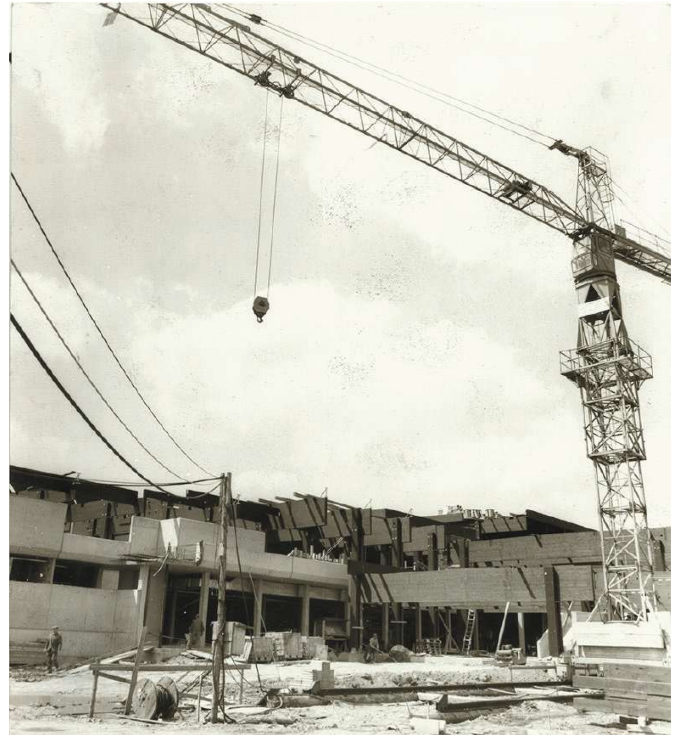
Abb. 33 – Bauphase Ansicht Vorplatz
