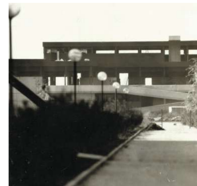
Abb. 39 – Bauphase, Zugang zum Wirtschaftshof
