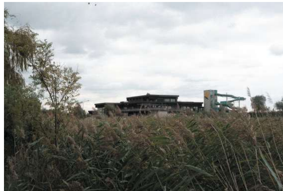
Abb. 72 – Hallenbad mit Rutschturm
