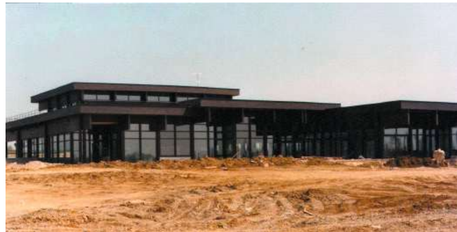
Abb. 29 – Bauphase, Rohbau mit bereits errichteter Glasfassade.
