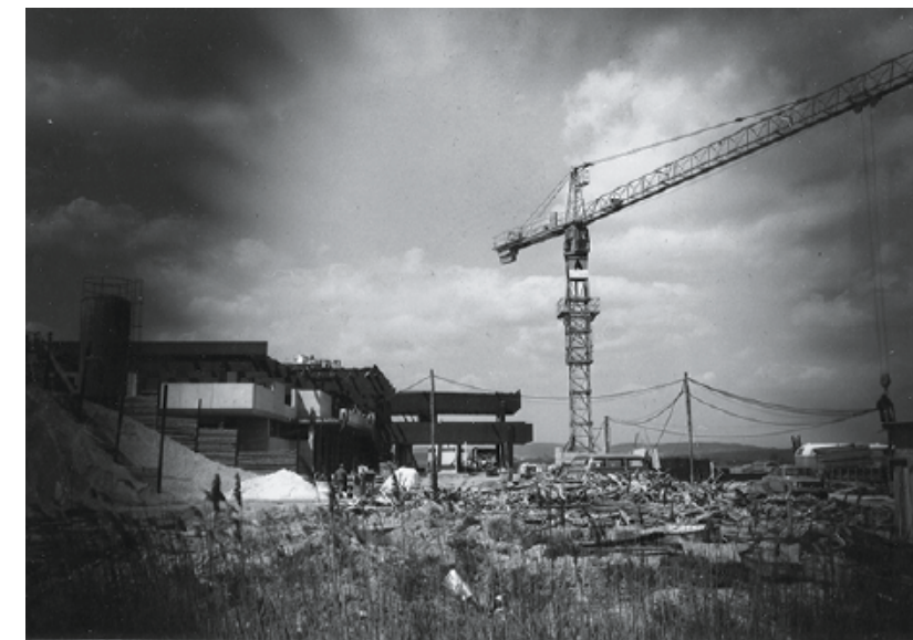
Abb. 28 – Bauphase, Ansicht Ost, Blick auf die Eingangshalle
