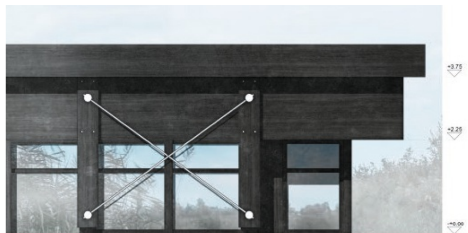
Abb. 34 – Glasfassade zwischen den Doppelstützen
