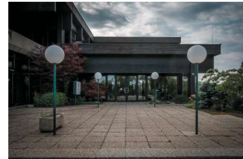
Abb. 84 – Eingangsbereich mit Vorplatz
