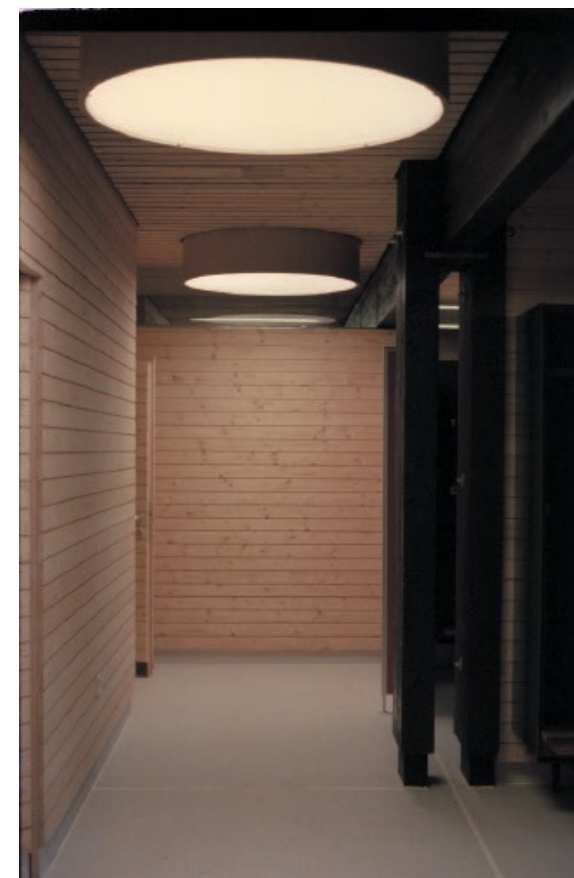
Abb. 44 – Bretterschalung im Saunenbereich mit Oberlichtern und sichtbarer Konstruktion, um 1977
