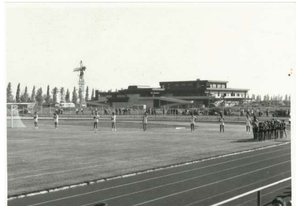
Abb. 115 – Sportplatzzeröffnung mit Hallenbad im Bauzustand im Hintergrund
