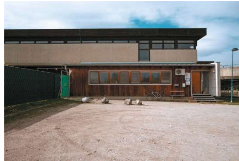
Abb. 76 – Zubau Büro durch Halbritter und Hillerbrand, Ansicht Ost
