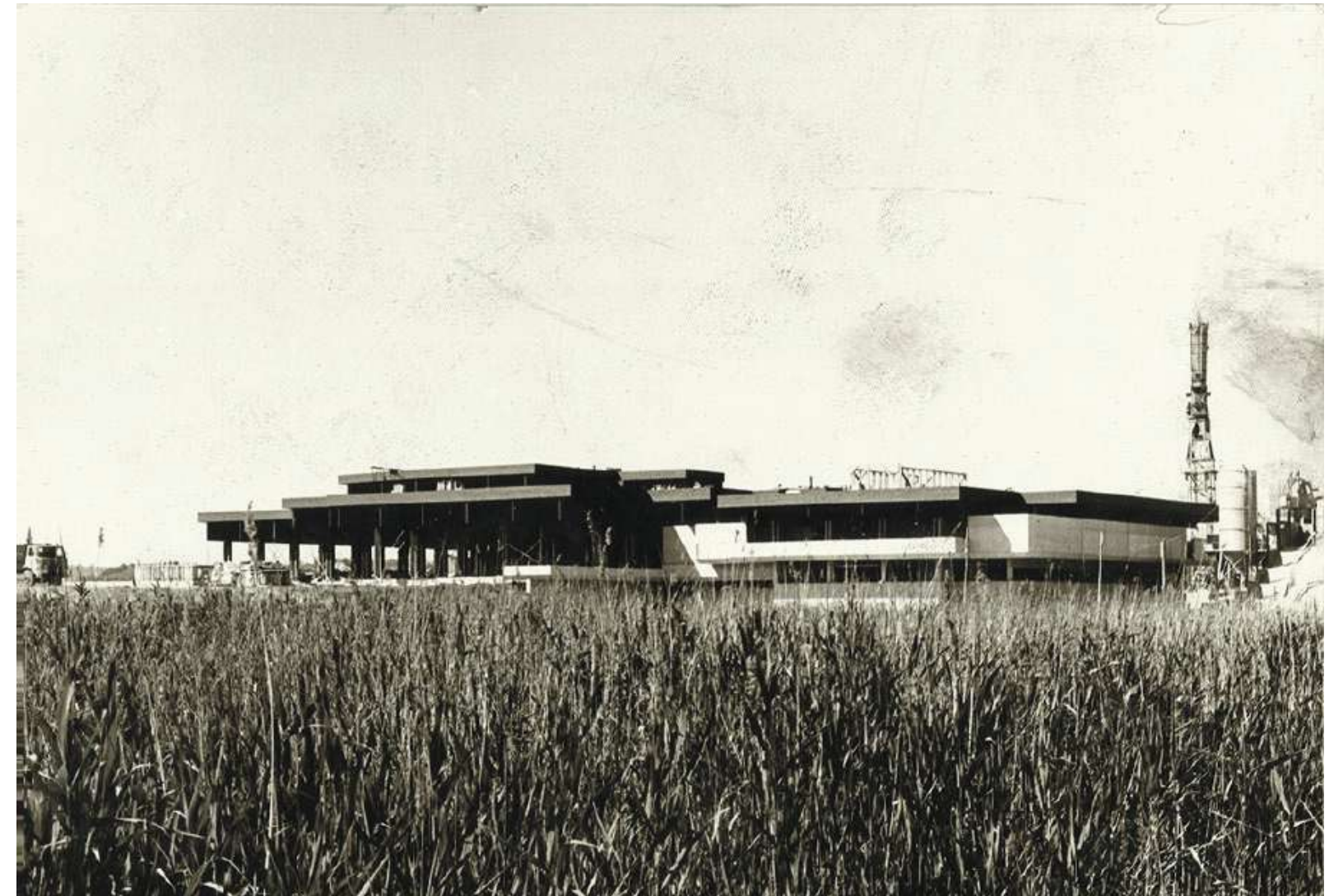
Abb.32 – Bauphase, Ansicht Süd -Robbau
