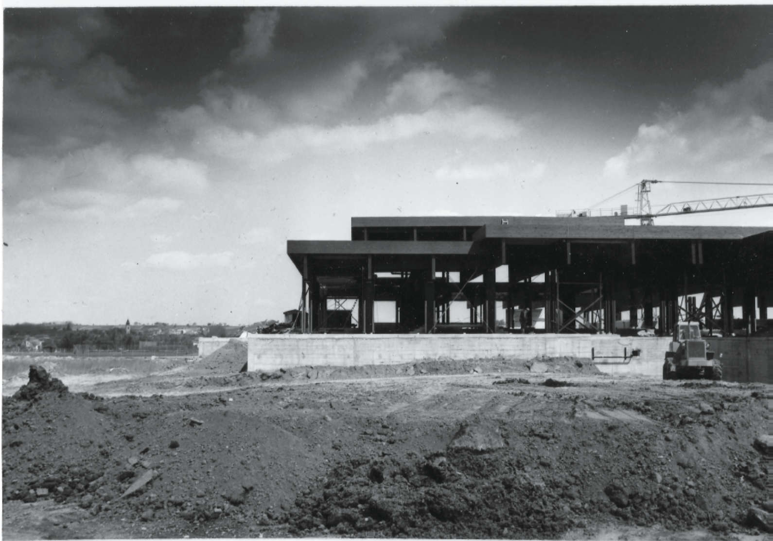
Abb. 26 – Bauphase, Ansicht Süd
