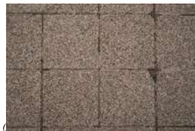
Abb. 102 – Bewitterte aber intakte Bodenplatten
