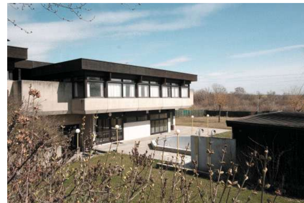
Abb. 73 – Ansicht Süd. Saumentrakt mit Zubau.
