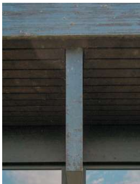
Abb. 94 – Binder im Eingangsbereich mit sichtlicher Behandlung der Hirnholzbereiche
