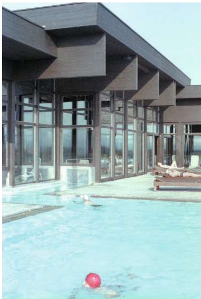
Abb. 51 – Originales Außenbecken, um 1977
