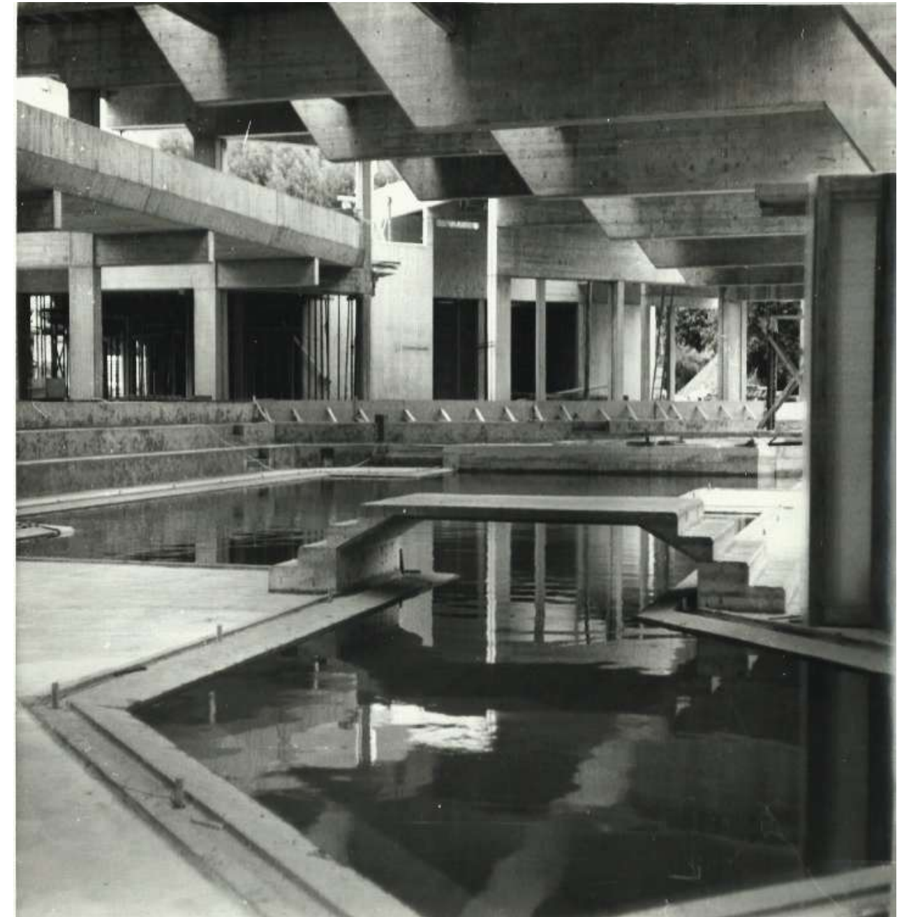
Abb.19 – Badehalle Kuranstalt Bad Hofgastein im Rohbauzustand
