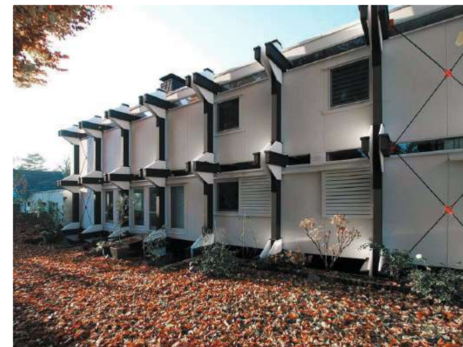
Abb. 83 – Haus Mayer Kuckuk nach den Sanierungsarbeiten
