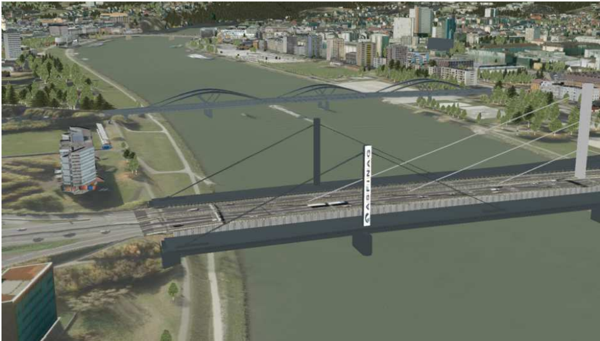
Abb. 33: 3D-Stadtmodell Linz (A7 Bypassbrücke und Neue Donaubrücke) (Screenshot, 3d.linz.at)
