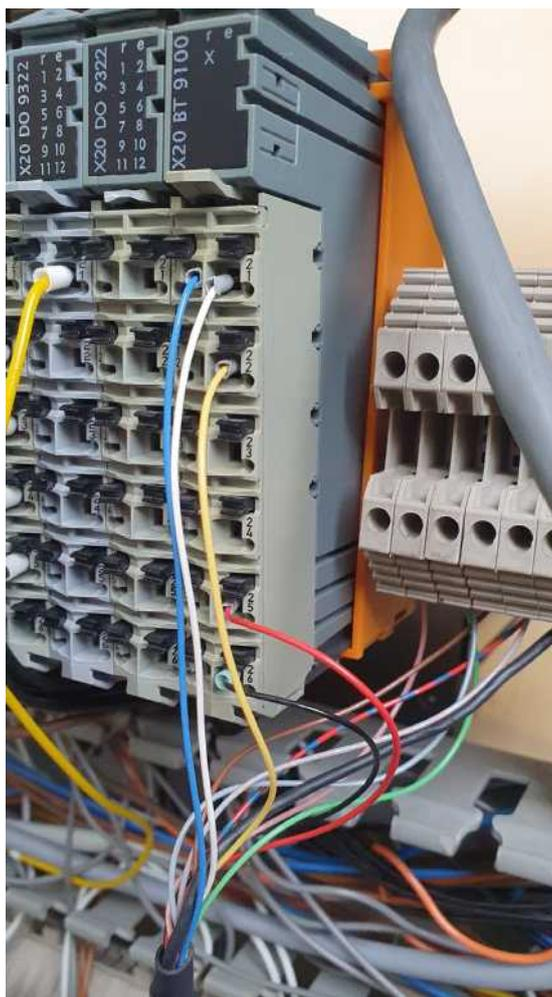
Abbildung 2.18.: Blick auf das Modul „X20BT9100“, das für die Kommunikation mit dem Handbediengerät zuständig ist, vor dem Umbau
