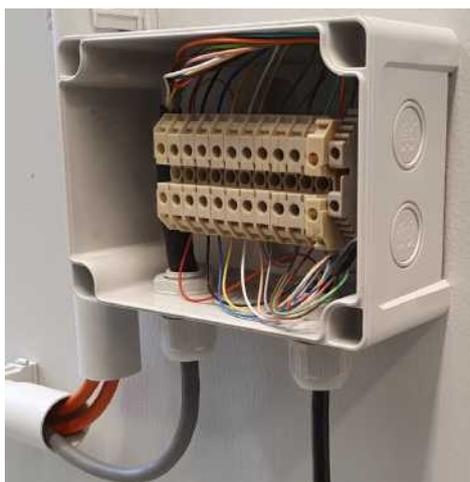
Abbildung 2.19.: Aufputzgehäuse zum Anschluss des Handbediengeräts
