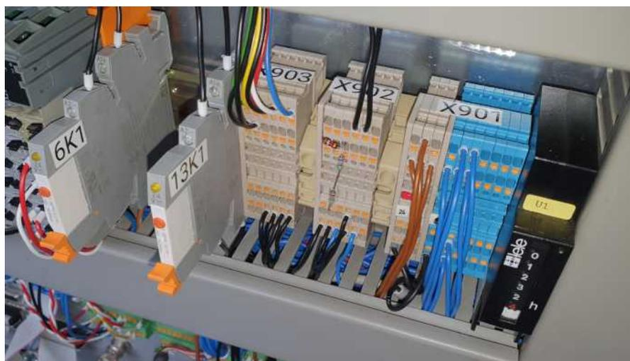
Abbildung 2.11.: Beschriftungen der Klemmen im Schaltschrank des Lasers
