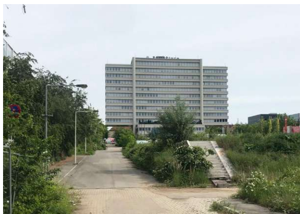
Abb.32: 4 Bauplatz Ansicht Philipps Haus
