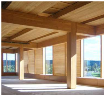
Abb.139: Holzskelett im Wood innovation Center
