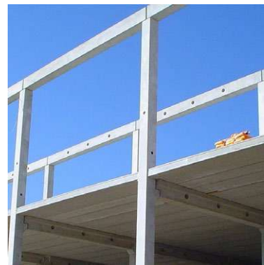
Abb.132: Vorgefertigte STB-Stabelemente
