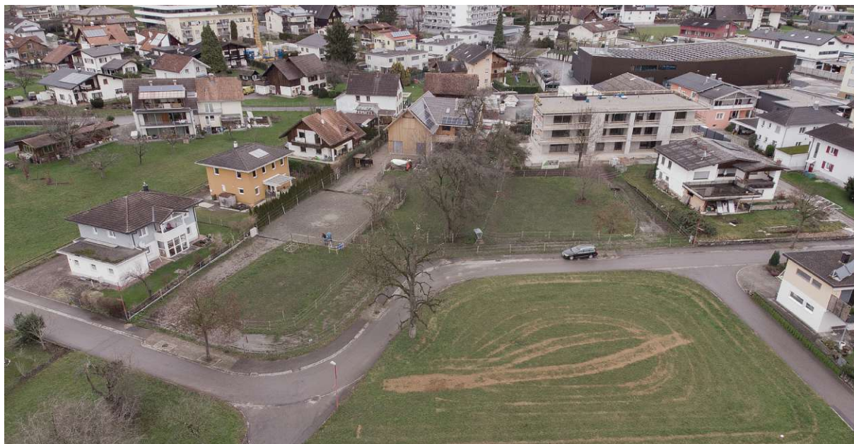
Bauplatz Nord- Ost
