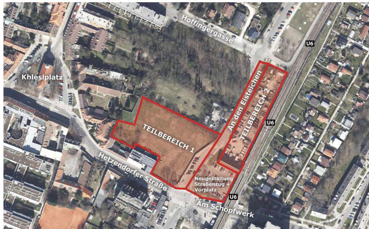
Abb.26: Übersicht Bauplatz , Unterteilung in Teilbereiche
