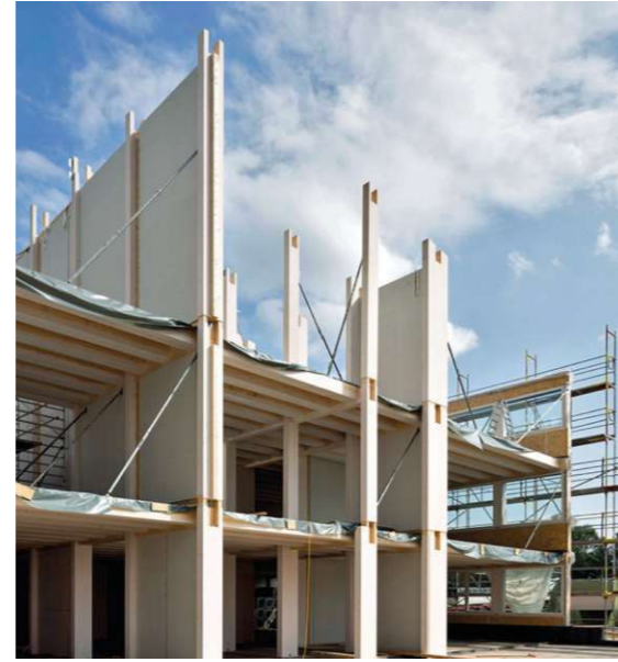
Abb.12: H-Stütze zur Aufhängung der Querträger
