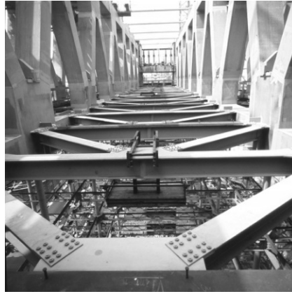
Abbildung 67: Auskreuzung Stahlfachwerk Juridicum Wien
