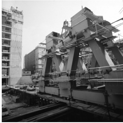
Abbildung 66: Stahlfachwerk Juridicum Wien
