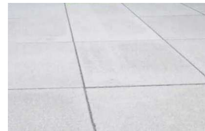
Abb. 134 - Lärchenholzfassade Ausschnitt - X (o.) Abb. 135 - Wege- und Terrassenplatten (u. re.)
