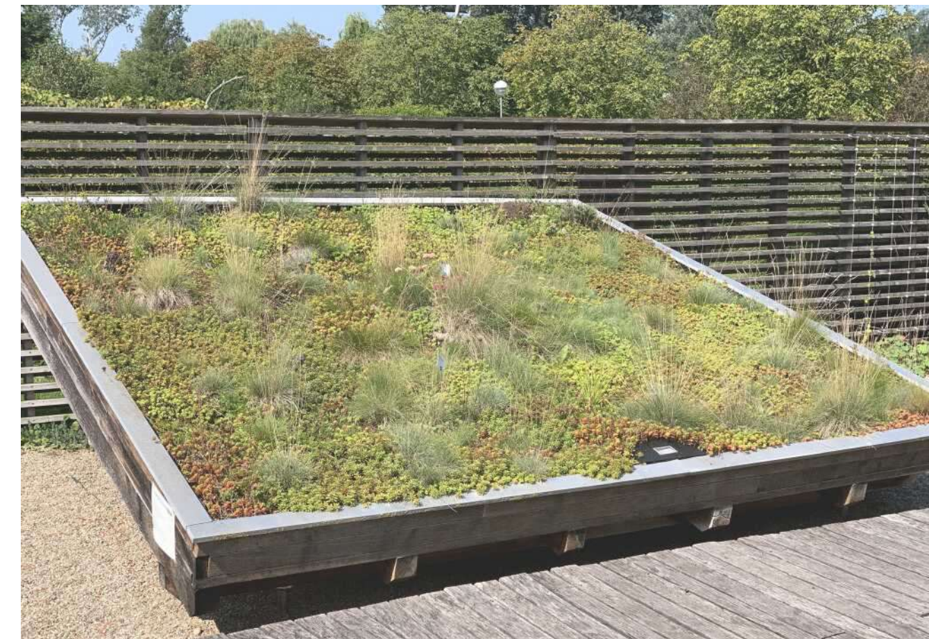
Abb. 152 - extensive Begrünung eines Daches
