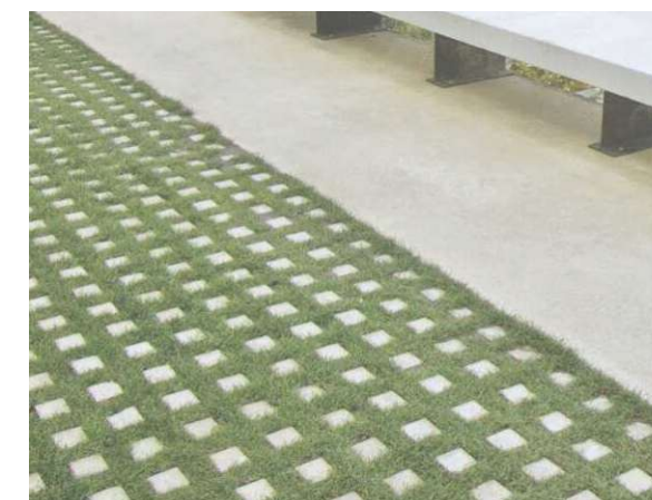
Abb. 133 - Rasengittersteine für Parkflächen
