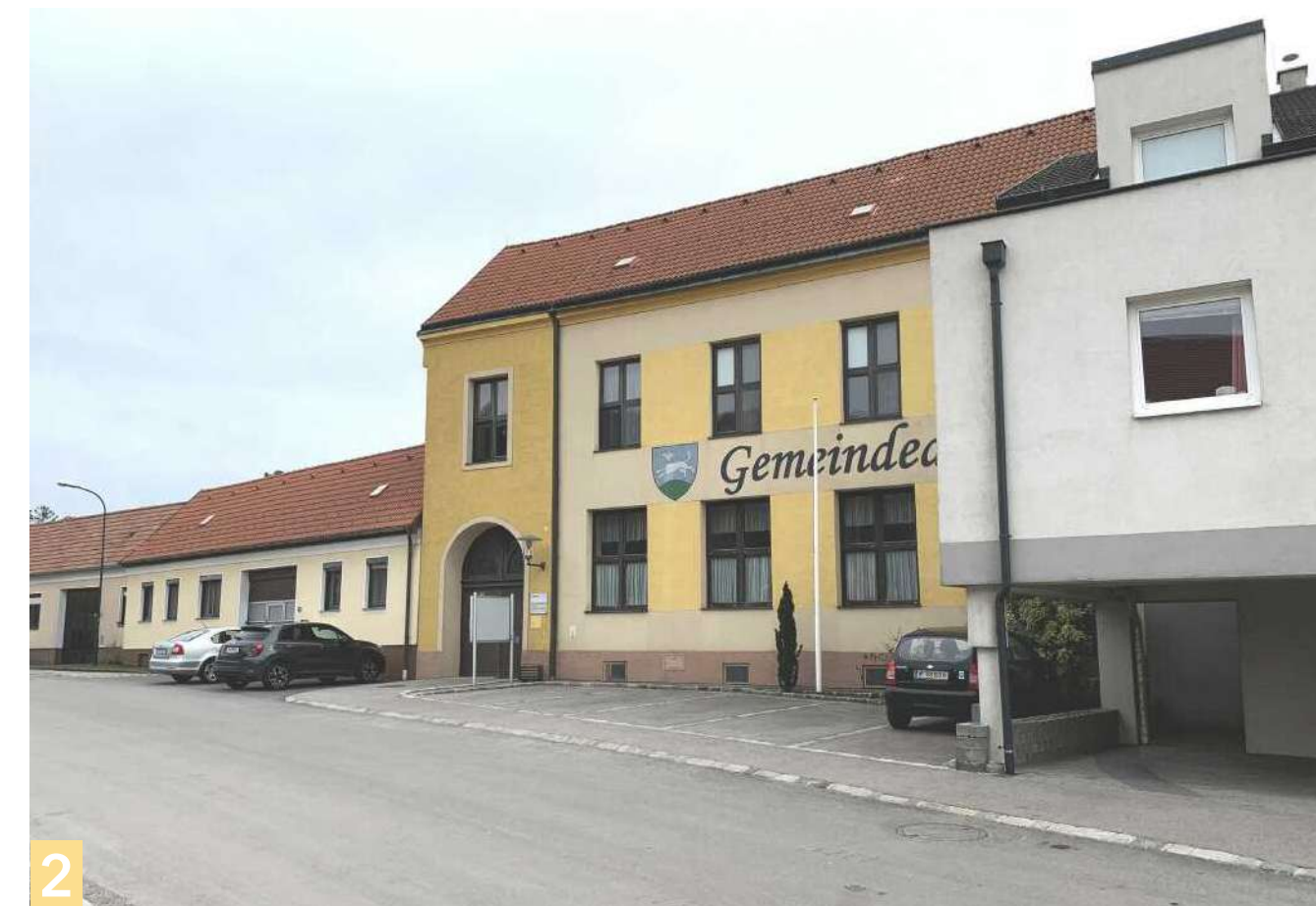
Abb. 57 - Liegenschaft - Hofseite (li.) Abb. 58 - Liegenschaft - Straßenseite (re.)
