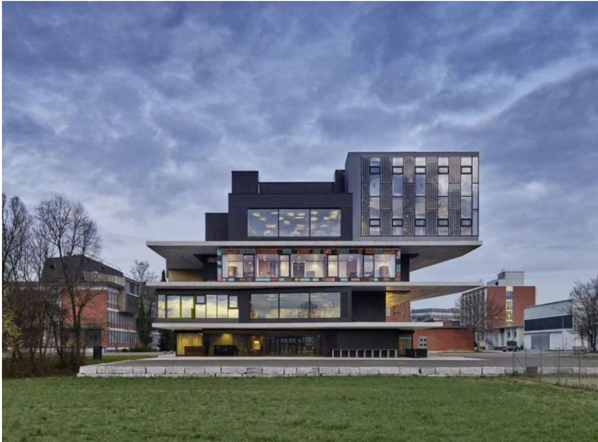
Abb. 4: UMAR Forschungsgebäude & NEST
