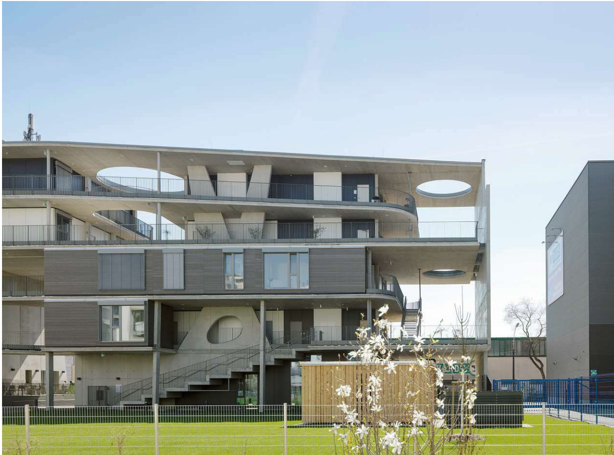
Abb. 1: Kiubo Wohngebäude Graz
