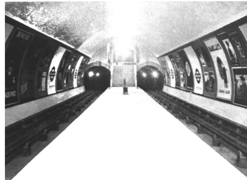
Bahnsteig der Londoner Underground
