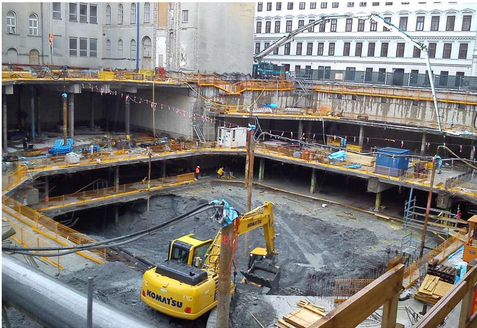
**Abb. 2.13:** Die Baugrube mit vier bereits hergestellten Deckenhorizonten
