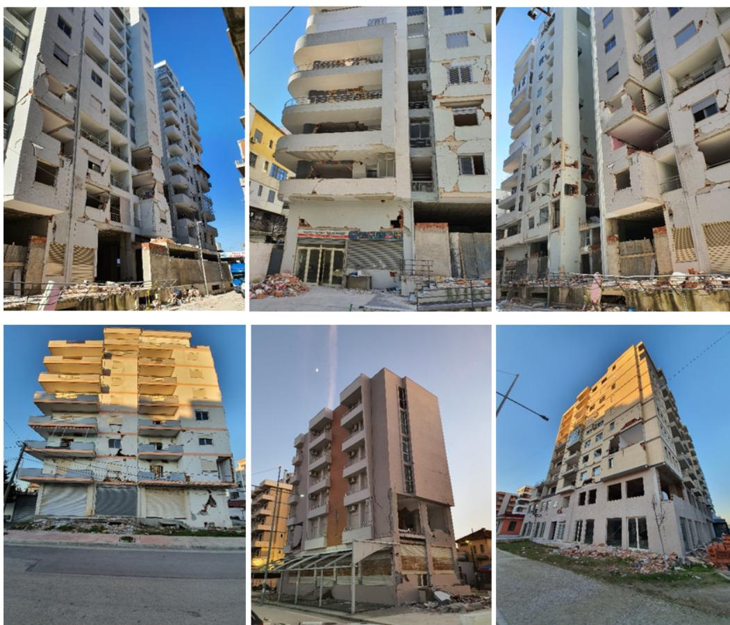
Abb. 2.14: Schäden an Hochbauten infolge des Durrësi-Erdbebens. Foto Verfasser.
