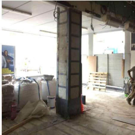
Abb. 5.14: Verstärkung der Stütze mit Stahlummantelung. Aus [33]
