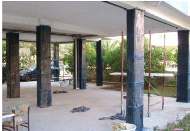
Abb. 5.16: Schubverstärkung von Säulen mit FRP-Ummantelung. Aus [33]
