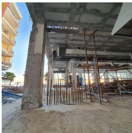
Abb. 5.8: Einbringen einer neuen STB-Wand. Foto Verfasser.
