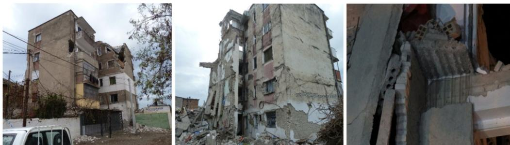
Abb. 2.13: Ein in Thumanë eingestürztes Gebäude mit lasttragenden Ziegelwänden und einfach stützenden Stahlbeton-Hohlkörperdecken [7]
