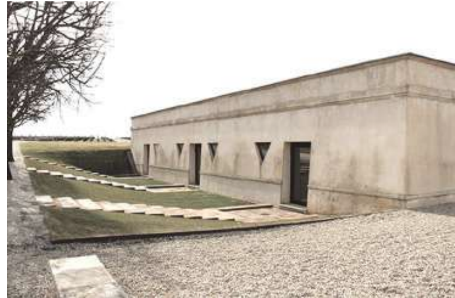
Abb.28: Erweiterung Château Pichon Longueville in Pauillac
