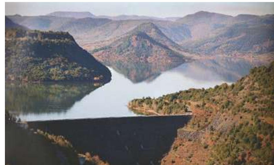
Abb.49: Staumauer des Lac du Salagou
