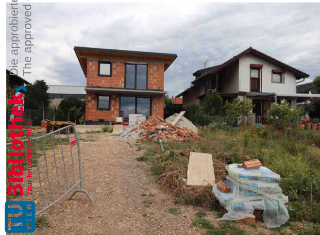
Abbildung 63f: Baustelle im KGV Frohsinn (Bernhard 2022)
