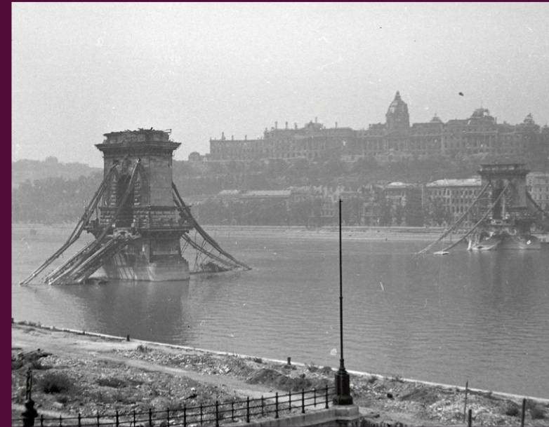
Abb. 1.18 Zerstörte Kettenbrücke Budapest, 1945
