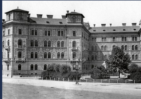
Abb. 3.18 Mietspalast Andrássy út 88 – 90 Budapest, um 1880
