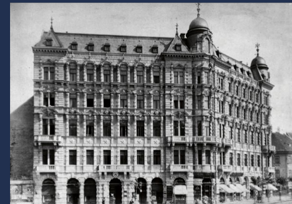
Abb. 3.21 Mietspalast Andrássy út 1 Budapest, um 1880
