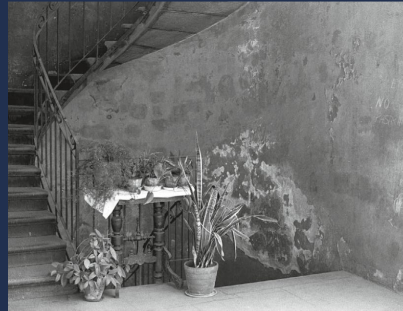
Abb.3.24 Dienststuppe in einem Hofhaus Budapest, 1983
