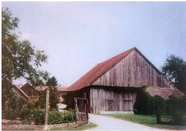
Abb. 122: Längsscheune in Neuaign vor der Umnutzung (Quelle: Amt der NÖ Landesregierung – Gruppe Baudirektion 2023a)
