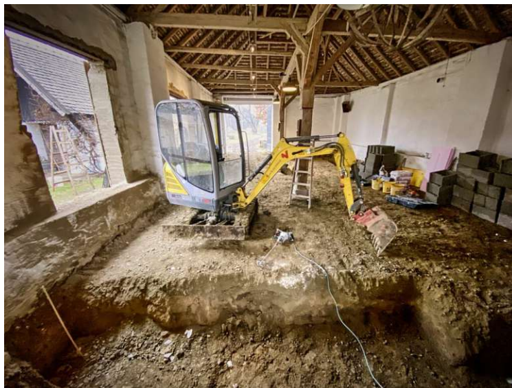
Abb. 129: Ausgrabung des Bodens und Herstellung des Fundaments (Quelle: Amt der NÖ Landesregierung – Gruppe Baudirektion 2023b)
