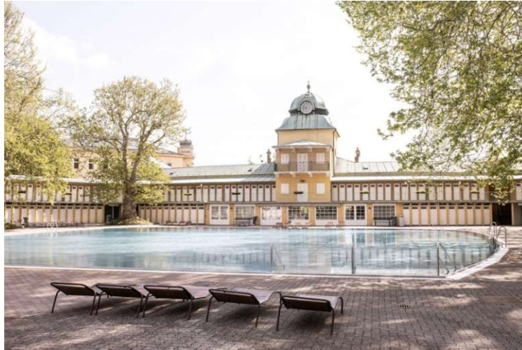
Abb. 45: Thermalbad Bad Vöslau (Quelle: Vöslauer Thermalbad GmbH 2023)
