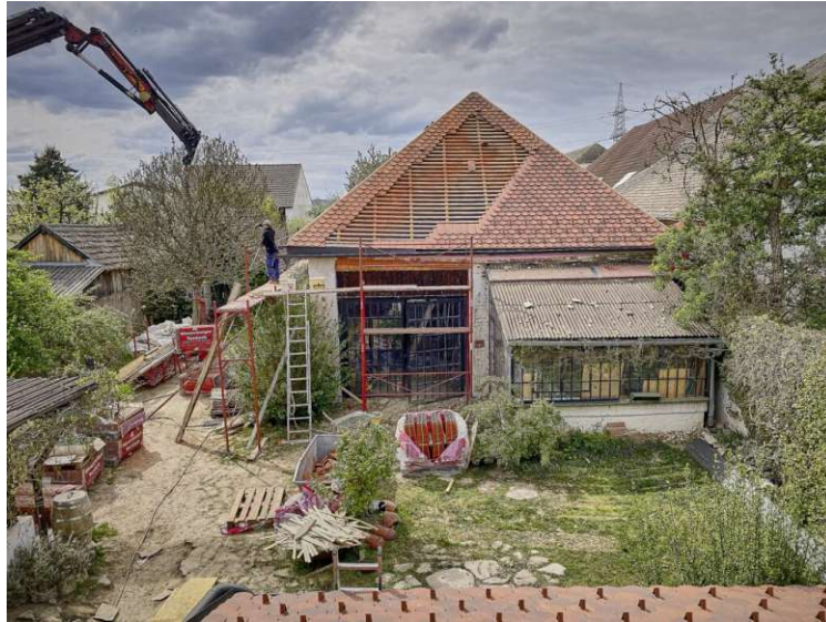
Abb. 130: Während der Bauarbeiten (Quelle: Amt der NÖ Landesregierung – Gruppe Baudirektion 2023b)
