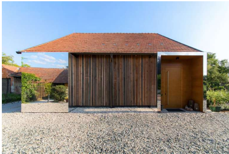
Abb. 125: Umgebaute Längsscheune Eingang (Quelle: Amt der NÖ Landesregierung – Gruppe Baudirektion 2023a)
