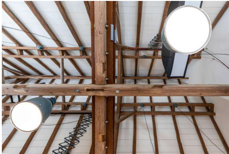
Abb. 128: Holzstruktur der Dachkonstruktion (Quelle: Amt der NÖ Landesregierung – Gruppe Baudirektion 2023b)
