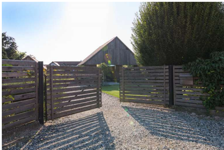
Abb. 123: Zugang von dem rückwertigen Hintausweg zur umgebauten Längsscheune (Quelle: Amt der NÖ Landesregierung – Gruppe Baudirektion 2023a)
