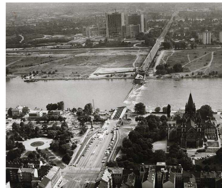
Abb. 6 Einsturz der Reichsbrücke 31. Juli 1976
