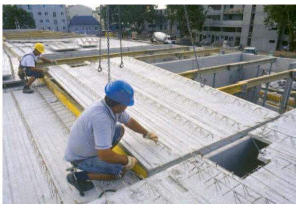
(a) Einheben und Justieren der Elementdecke [55]
