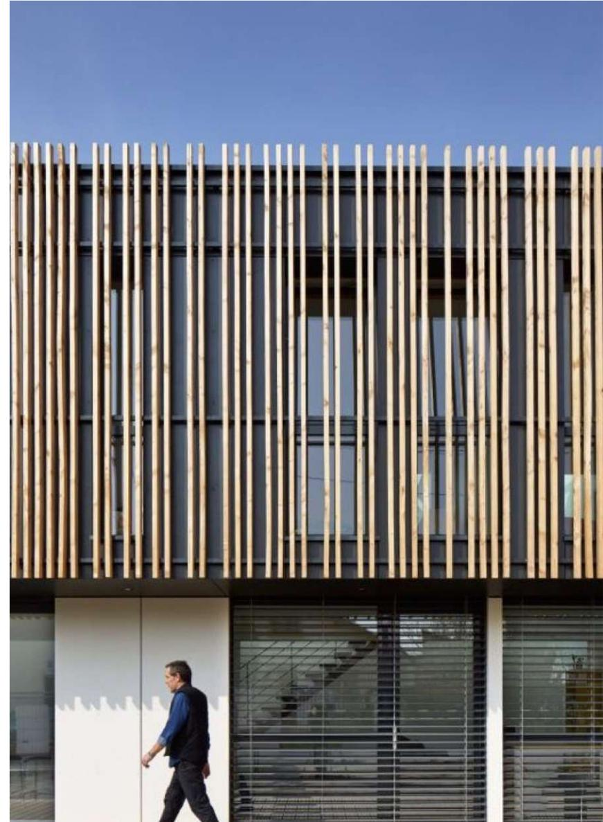
Abb. 92 Holzlamellenfassade aus Lärche auf verputztem WDVS
