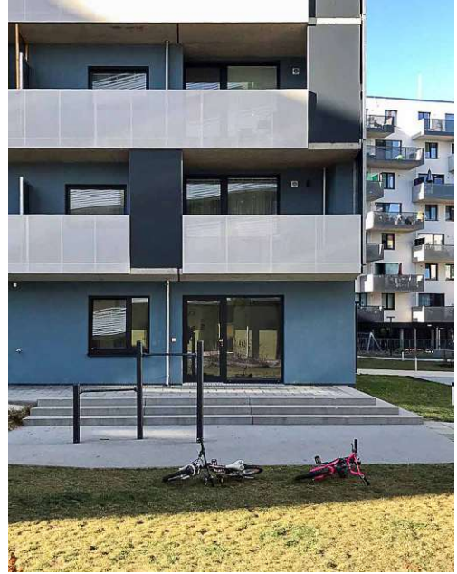
Abb. 48 Bauplatzübergreifender Fitnessraum (sh)
