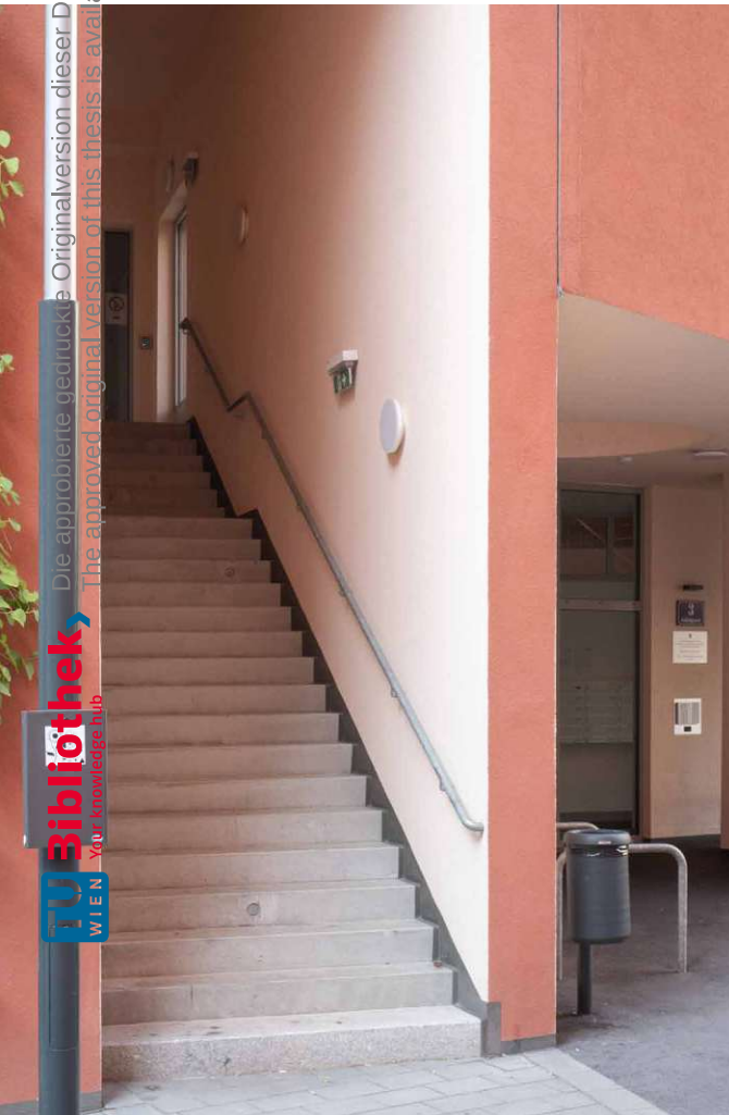
Abb. 65 Foto: Biotope City, Zugang zu bauplatzübergreifenden Gemeinschaftsräumen im Obergeschoss der Mikrozone (sh)
