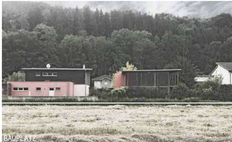
Abb.5(A) - bauplatz von norden
