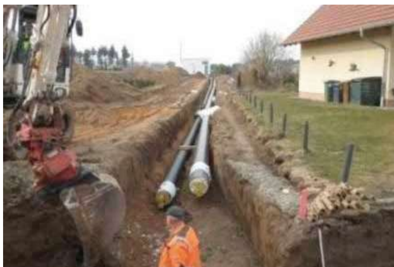
Abb.20 (14) - nahwärmenetz
