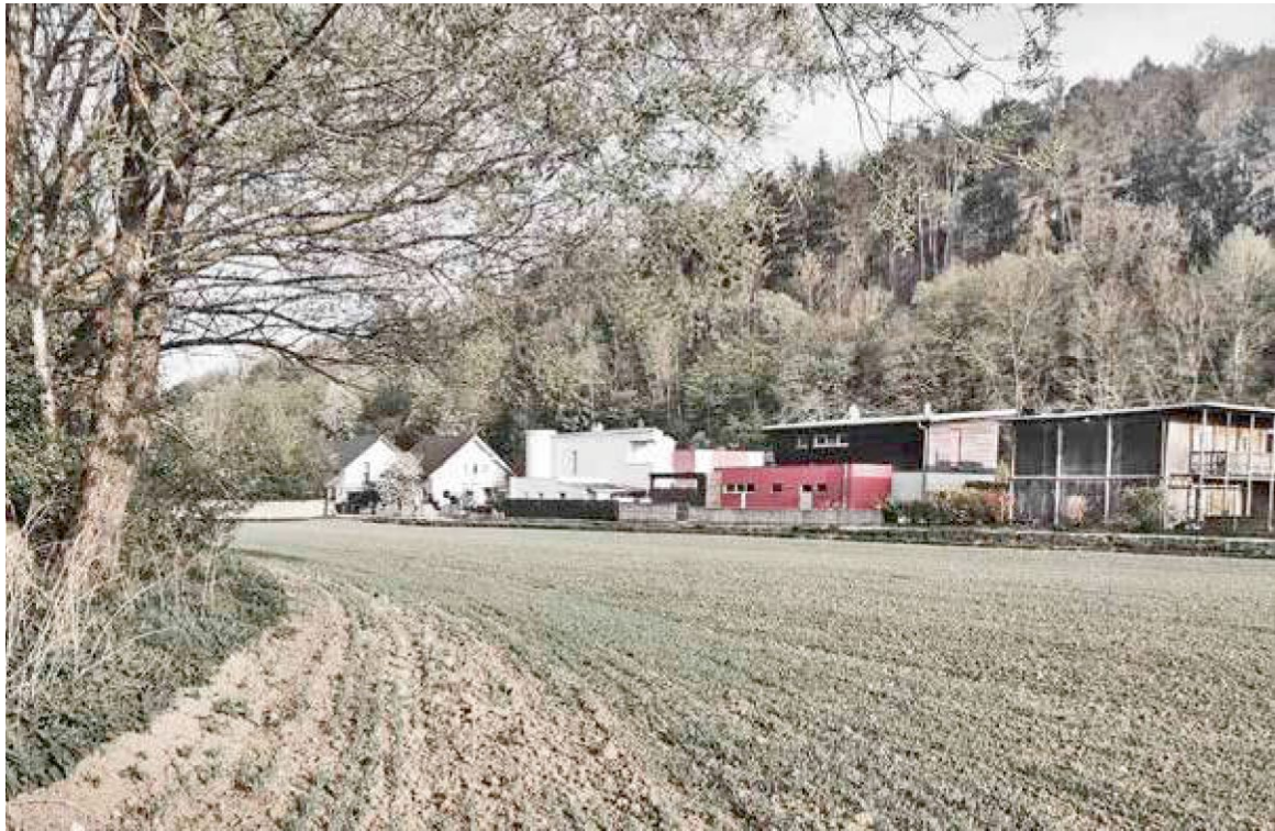
Abb.18(A) - bauplatz von nordwesten
