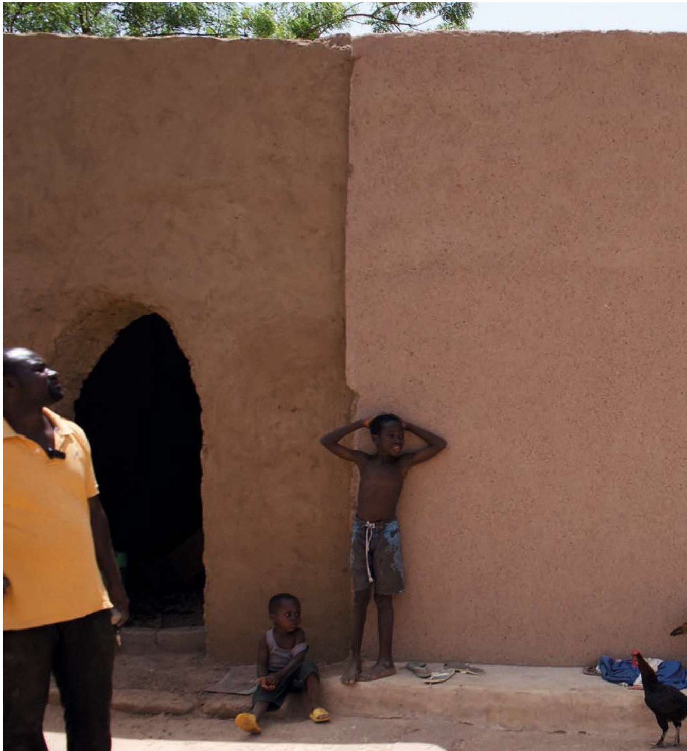
Abb. 186 | Die nachträglich errichtete zweite Räumlichkeit - Gewölbe an Gewölbe.
