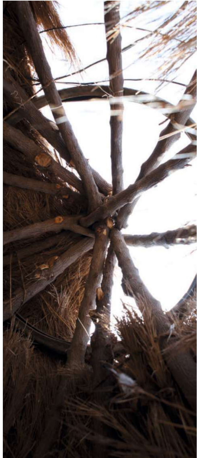
Abb. 66 | Kegeldachdeckung
