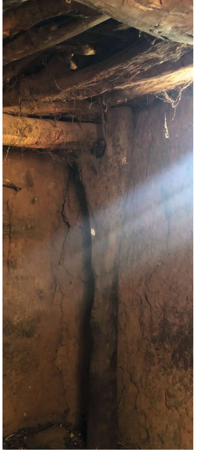
Abb. 64 | Stütze einer Flachdachkonstruktion
