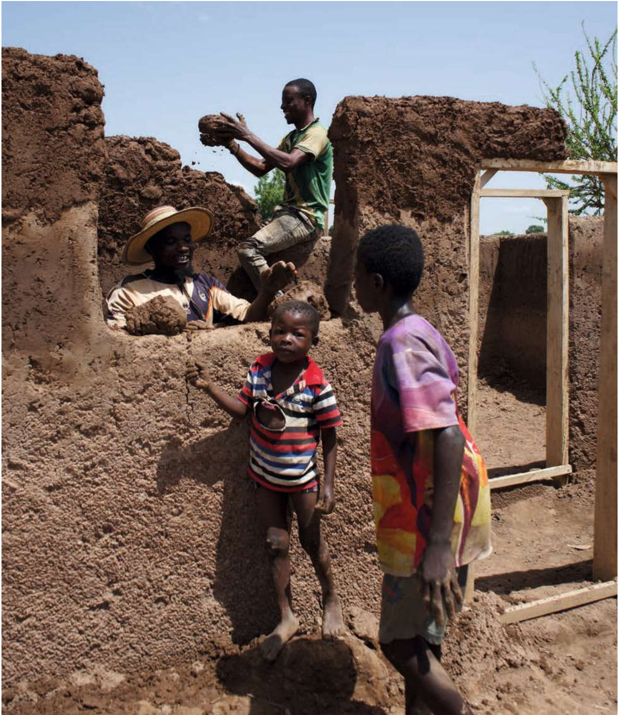
Abb. 56 | Der Baumeister positioniert die Lehmpatzen
