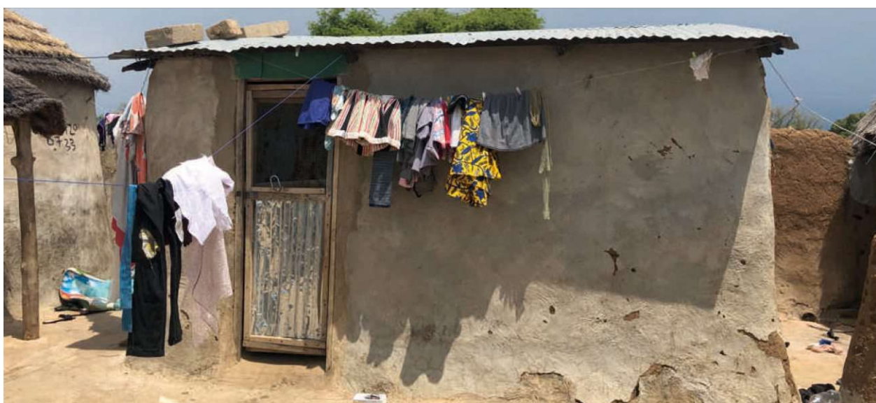
Abb. 122 | Das rechteckige Schlafhaus mit Zinkdach
