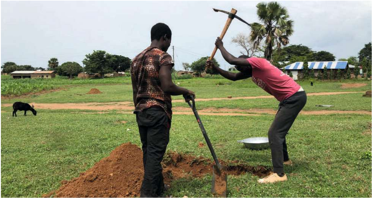
Abb. 212 | Erste Sondierung des unbebauten NONGRE Grundstücks
