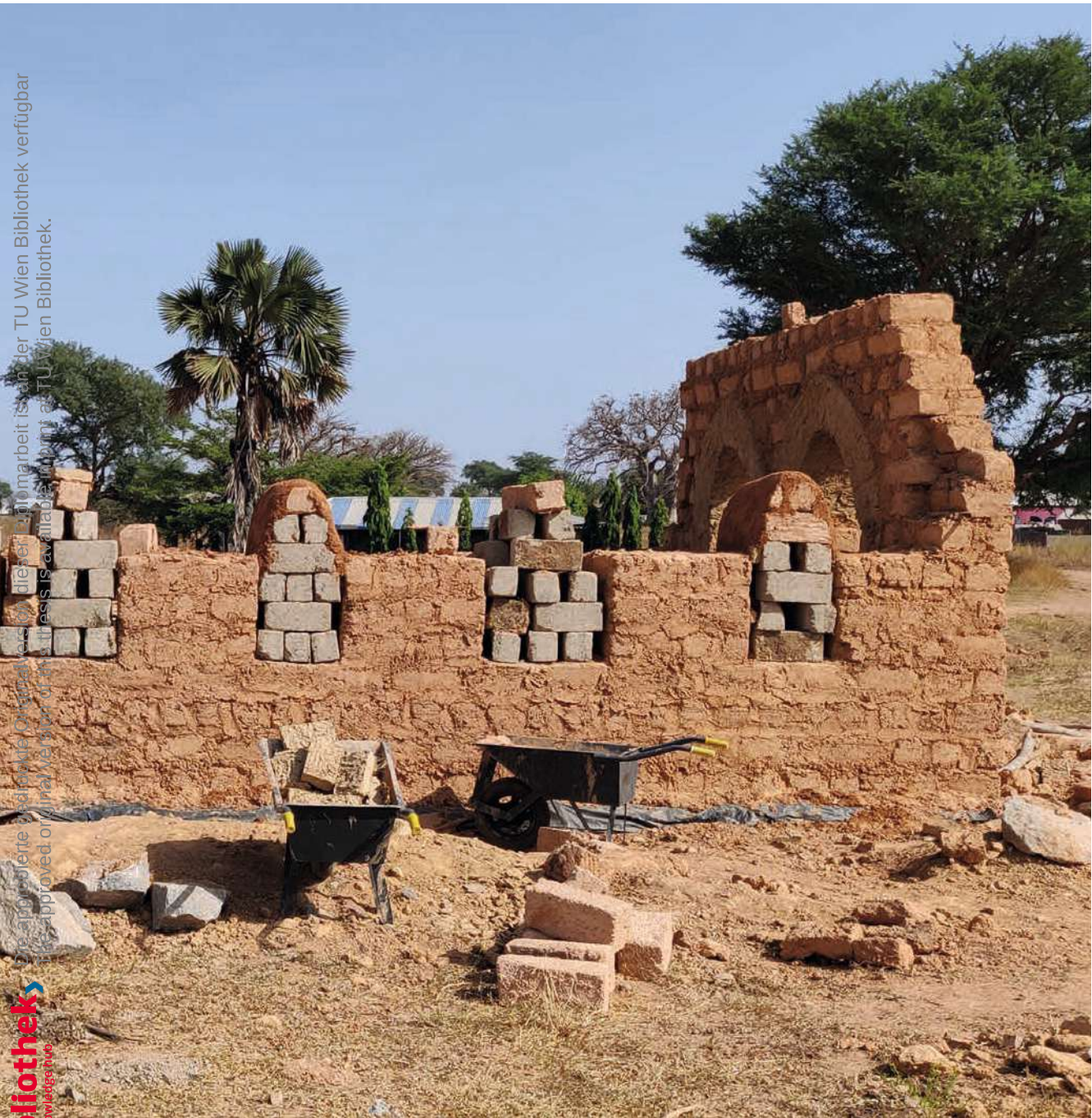
Abb. 169 | Die Hilfskonstruktionen für die zukünftigen Fensteröffnungen
