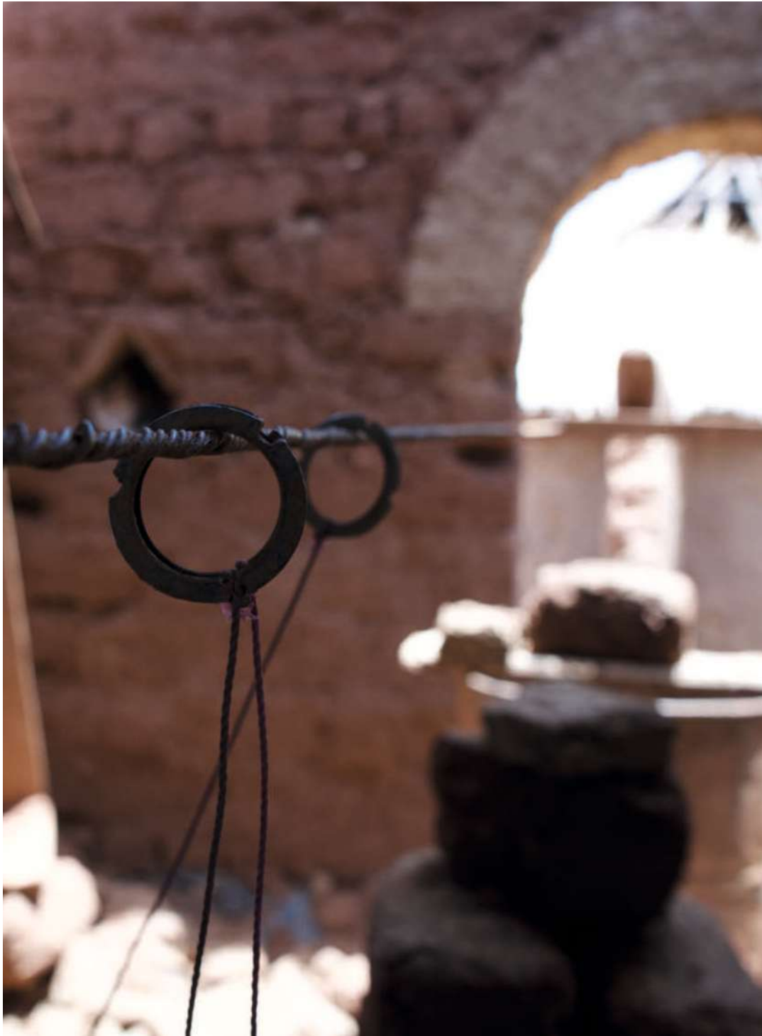
Abb. 179 | Ein aufgespanntes Kabel für die Installation eines nubischen Gewölbes
