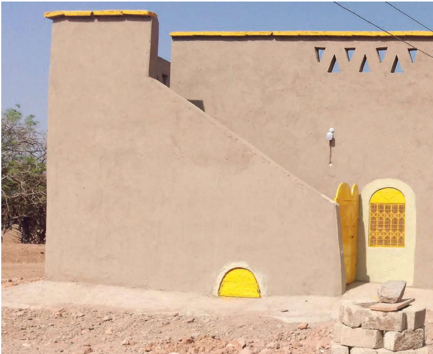
Abb. 291 | Das erste Gebäude des neuen NONGRE Kulturzentrums
