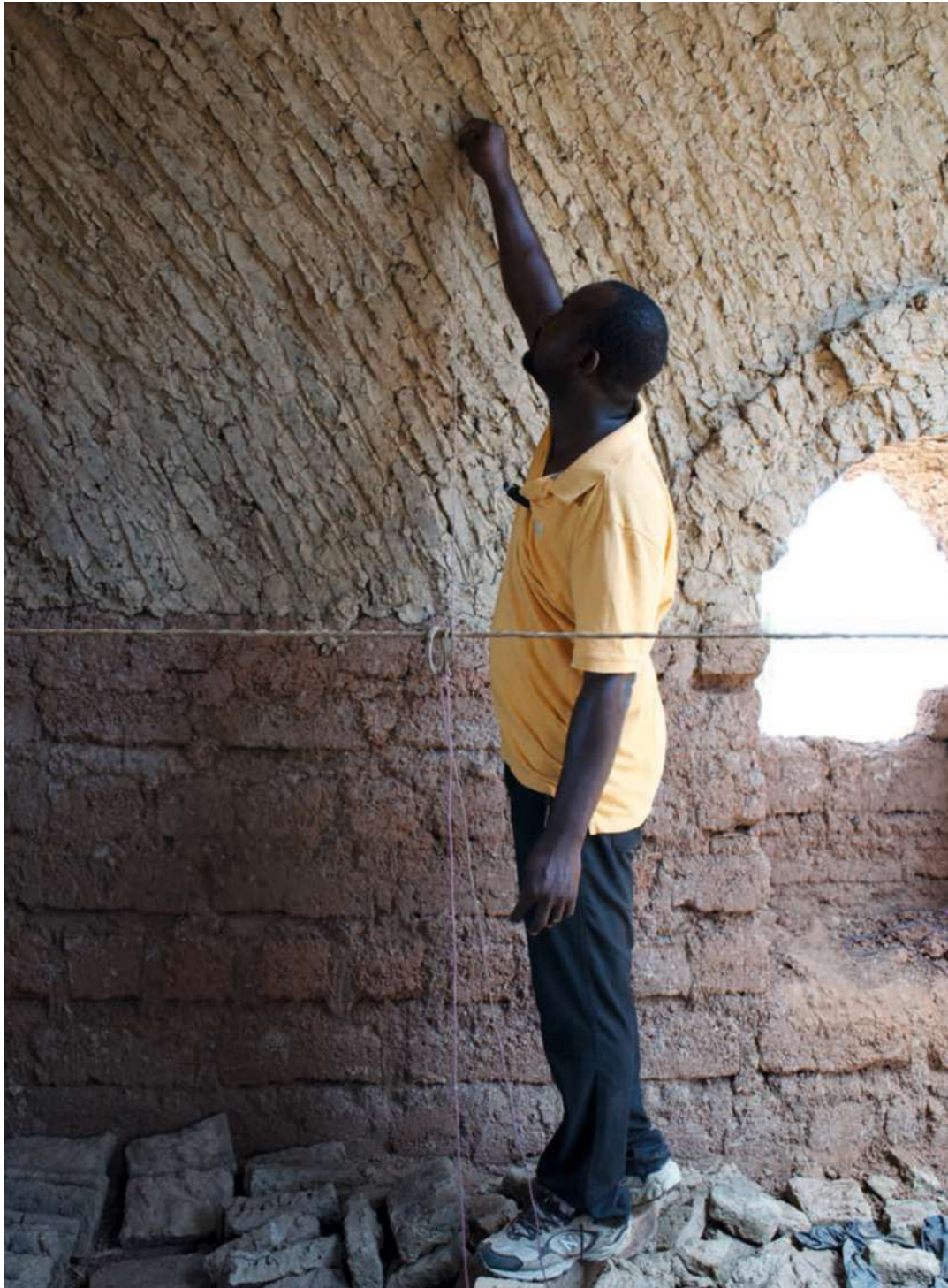
Abb. 180 | Die Seilführung zur Erstellung des Nubischen Gewölbes
