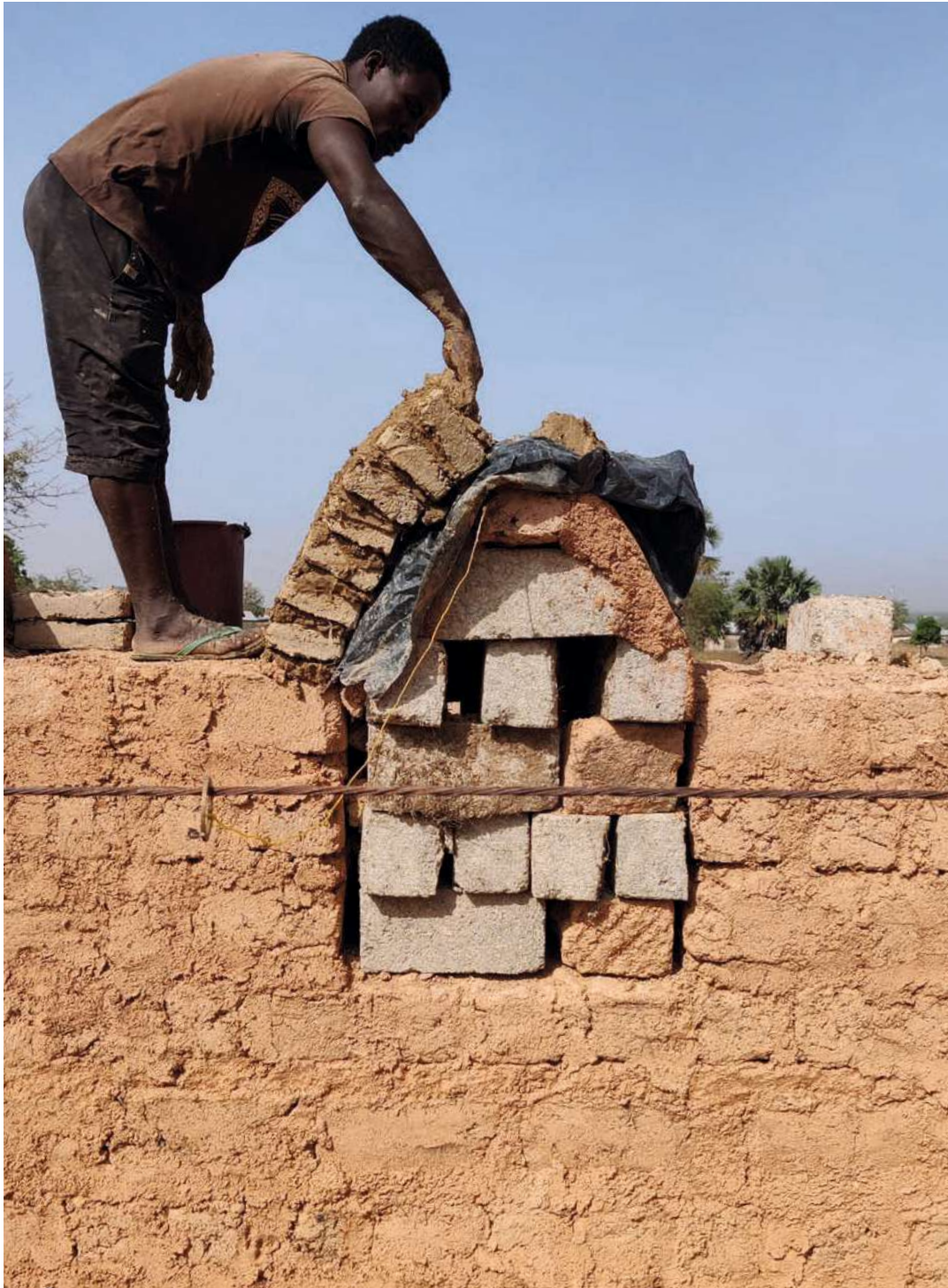
Abb. 170 | Die Errichtungskonstruktion einer zukünftigen Mauerwerksöffnung
