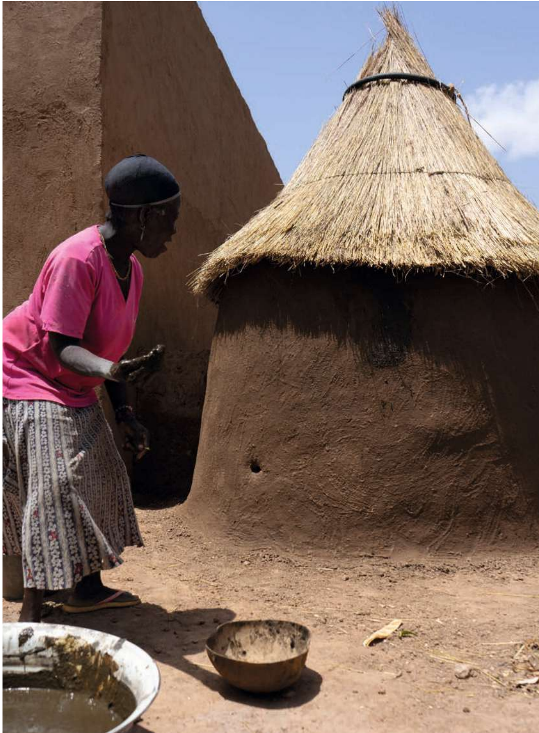
Abb. 23 | Erneuerung des Putzes eines traditionellen Hauses
