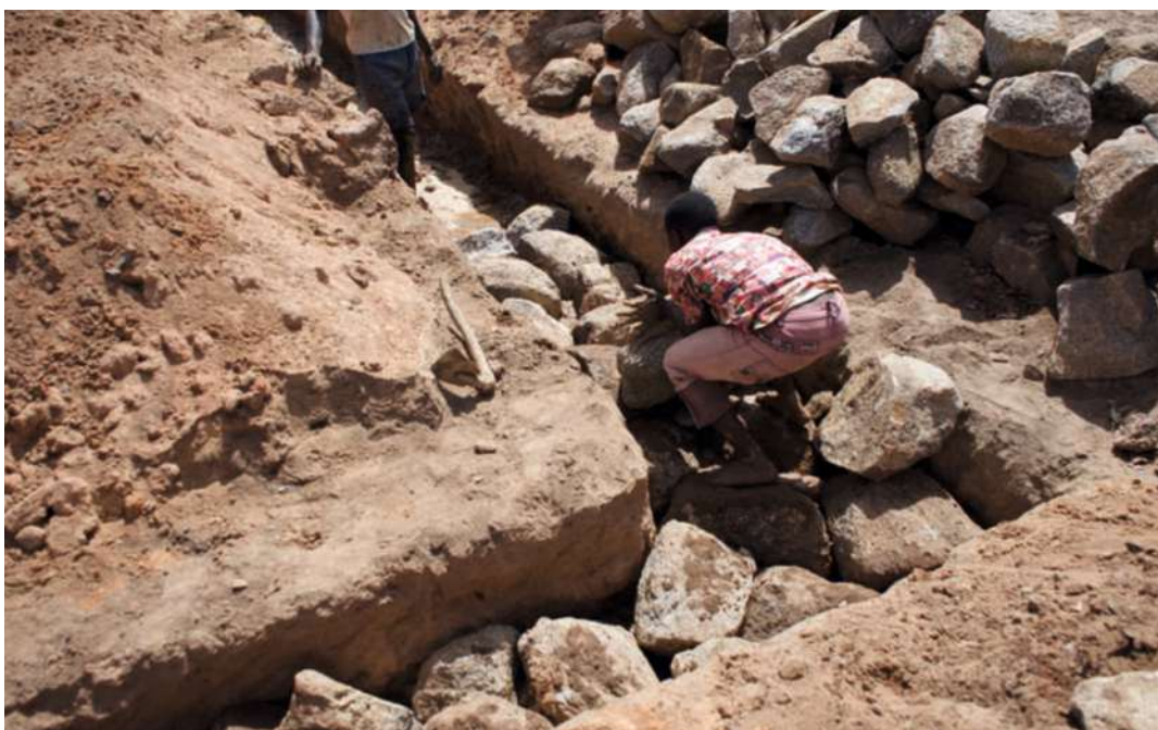
Abb. 139 | Fundierungsarbeiten in Garu
