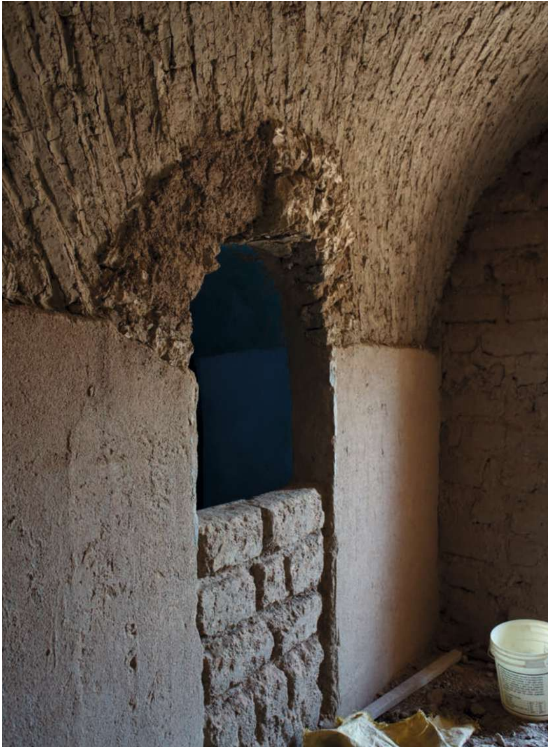
Abb. 185 | Zubau eines neuen Gewölbes bei einer bestehenden Struktur
