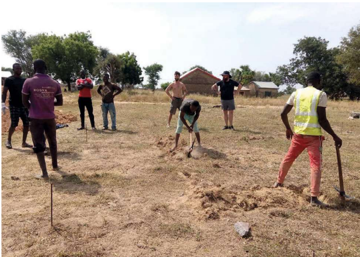
Abb. 198 | Spatenstich am 25.11.2022, mit AVN, NONGRE und TU Wien
