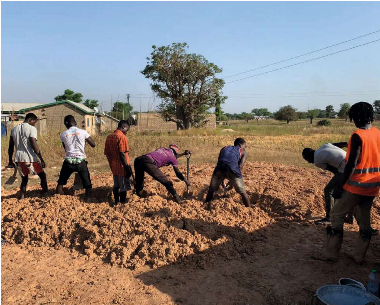
Abb. 49 | Die traditionelle Vorbereitung der Lehmmischung
