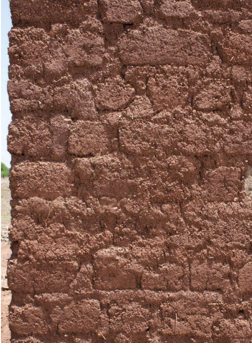
Abb. 148 | Mauerwerk aus luftgetrockneten Lehmsteinen in Garu
