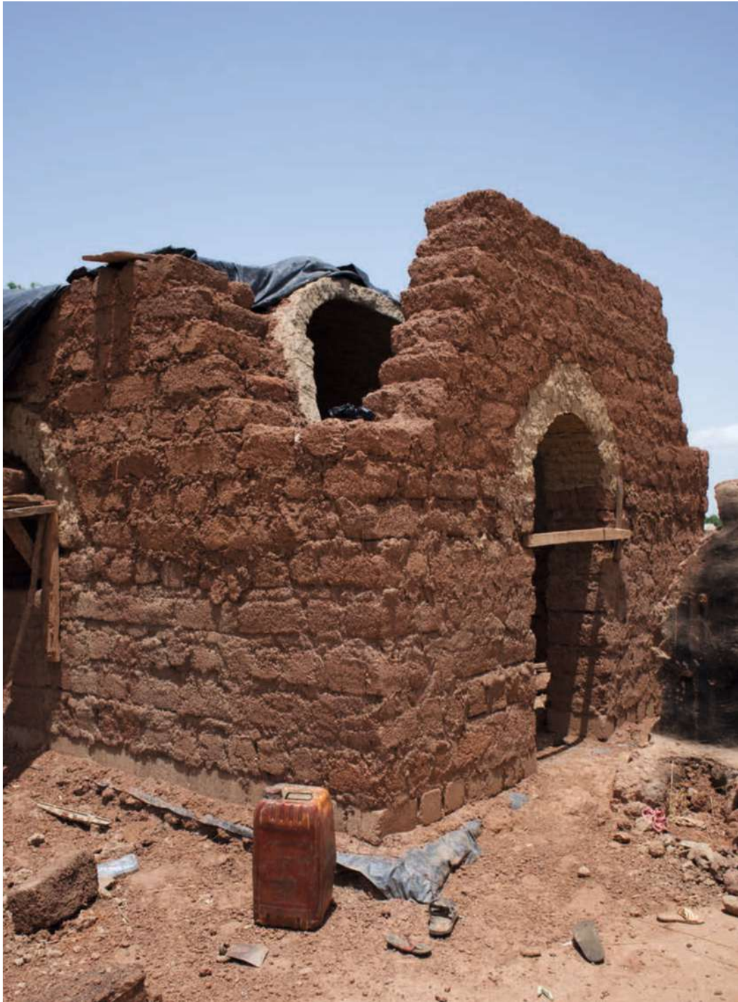
Abb. 183 | Ein nahezu fertig vermauertes Gewölbe in Garu
