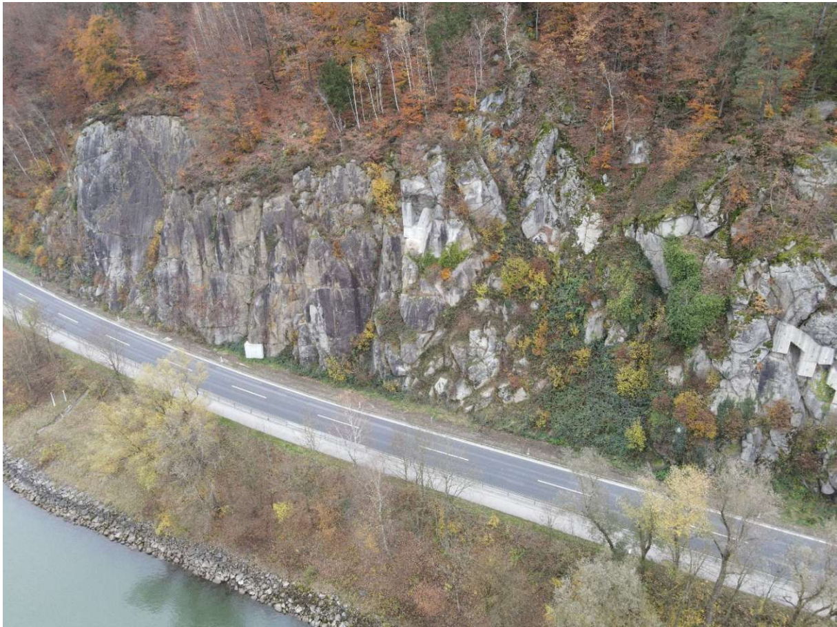
Abb. 5.1: DJI_0993 Luftaufnahme der Felswand (© Mariella Illeditsch): Zu sehen sind der Bewuchsgrad zum Zeitpunkt der Aufnahmen und die Lage von Ankerbalken bzw. Stützkörper (links - an der Straße, Mitte - oben, rechter Rand des Bilds - mittlere Höhe. Quelle: NÖ KSG
