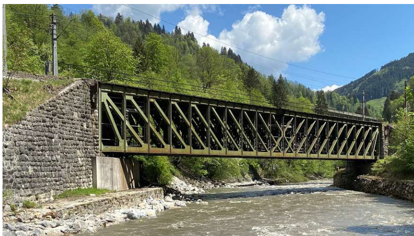
Abb. 3.1: Untersuchte genietete Stahlfachwerkskonstruktion aus dem Jahr 1915
