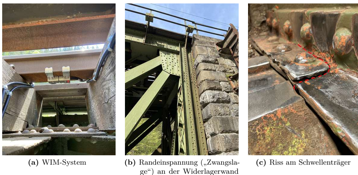
Abb. 3.4: Details des untersuchten Tragwerks
