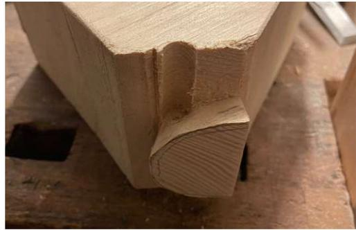
Übertragen der Verbindung auf das Mittelsegment, Ausstemmen der Ausnehmung für den Schwalbenschwanz mittels Stemmeisen.
