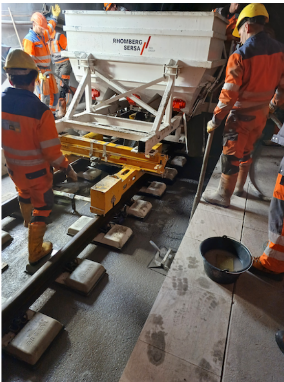
(c) Einbringen des Betons
