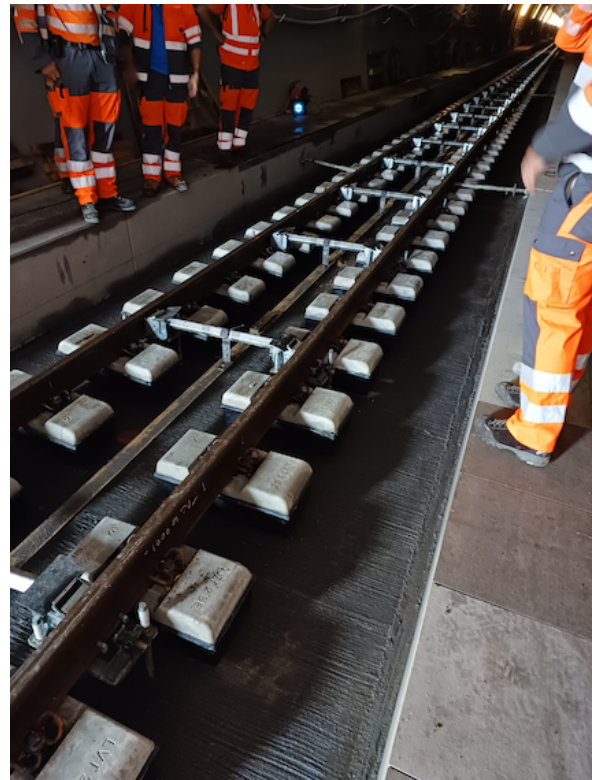
(b) Fixierter Gleisrost vor der Betonage
