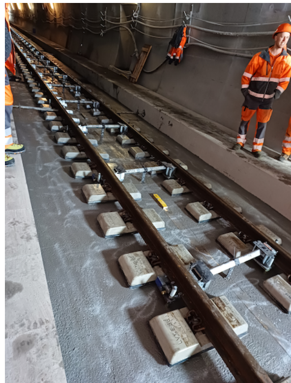
(d) Noch nicht ausgehärtete Feste Fahrbahn
