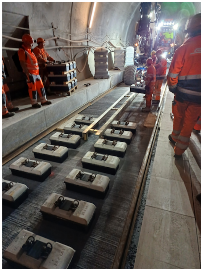
Abb. 4.13: Auflegen der Schwellen im Albulatunnel [eigene Aufnahme]
