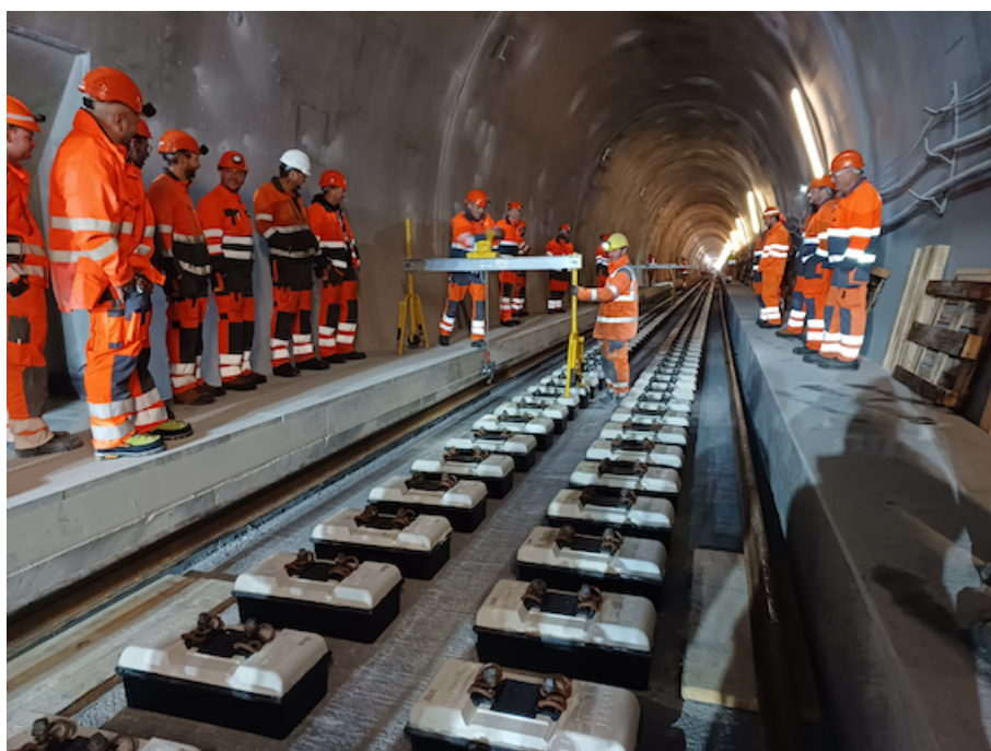
Abb. 4.15: Montage der Schienen im Albulatunnel [eigene Aufnahme]
