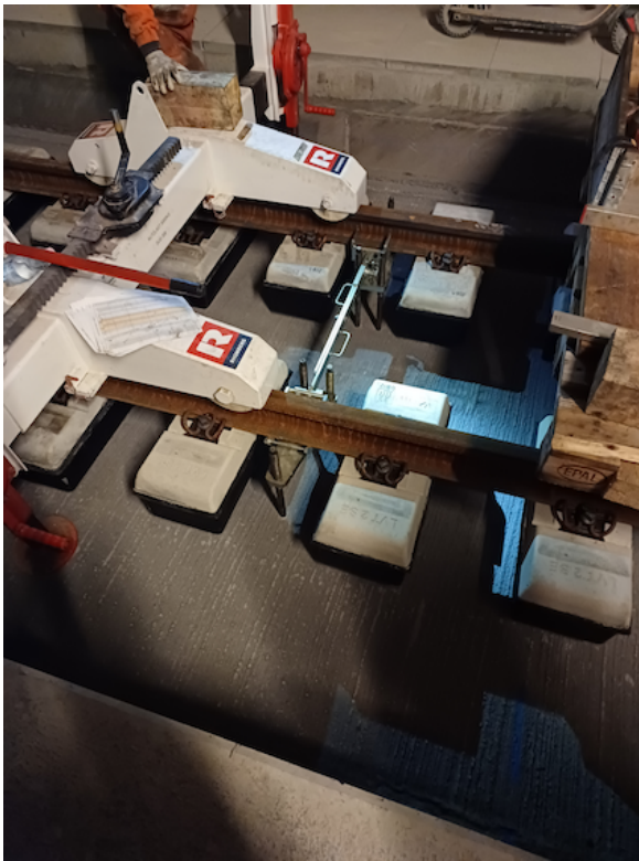
(a) Grobrichten des Gleisrosts
