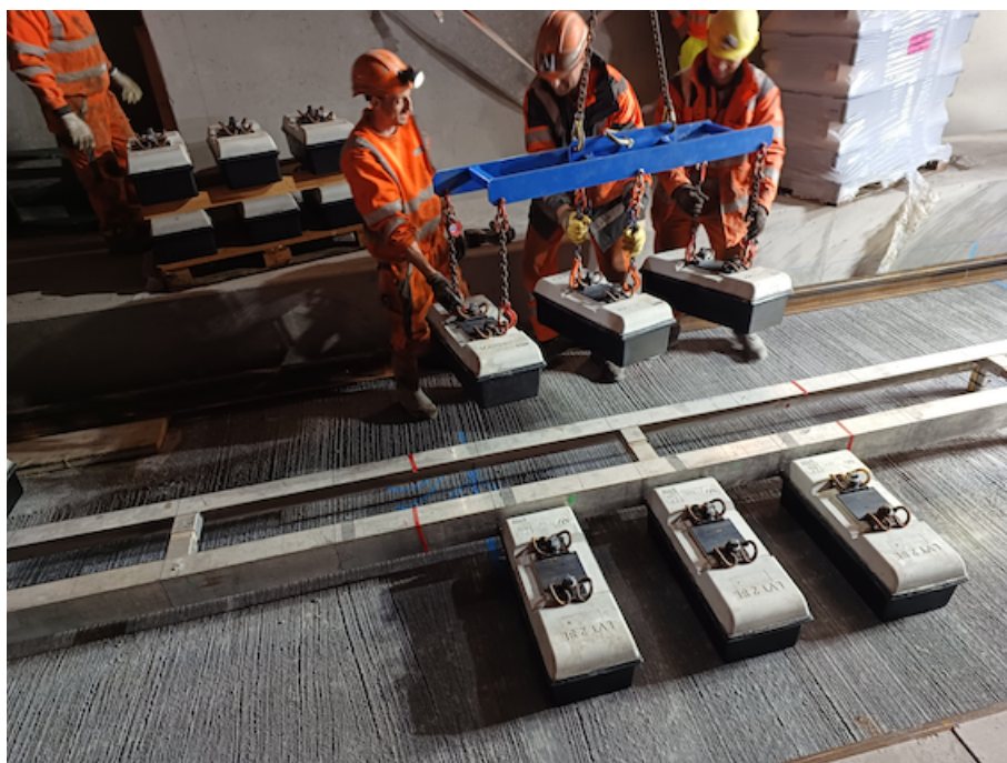
Abb. 4.14: Auflegen der Schwellen im Albulatunnel [eigene Aufnahme]
