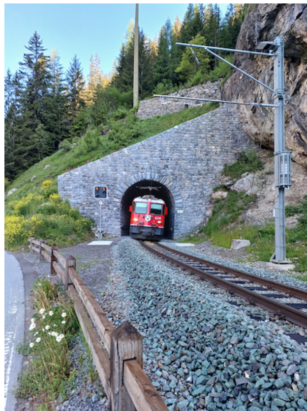
Abb. 6.1: Portal des sanierten Berggütersteintunnels [eigene Aufnahme]
