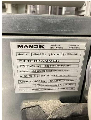
(a) Typenschild einer Lüftungsanlage
