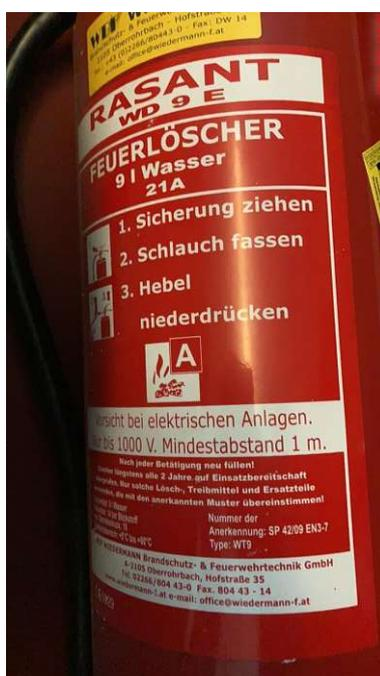
**Abb. 5.6:** Typenschild eines Feuerlöschers
