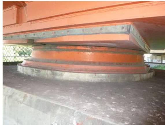
Abb. 22 Handelskai horizontales Topflager
