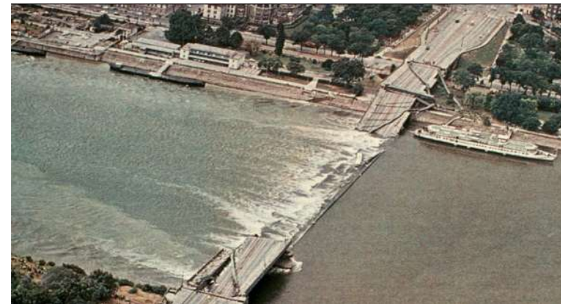
Abb. 08 Einsturz der Reichsbrücke
