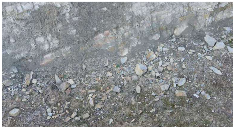
Abb. 7.11: Herabfallendes Gesteinsmaterial am Böschungsfuß (Aufnahme vom 02.03.2023; Alexander Preh, Mariella Illeditsch)
