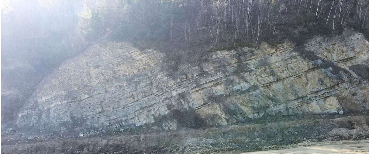
Abb. 7.4: Untersuchte Felsböschung (Aufnahme vom 02.03.2023; Alexander Preh, Mariella Illeditsch)
