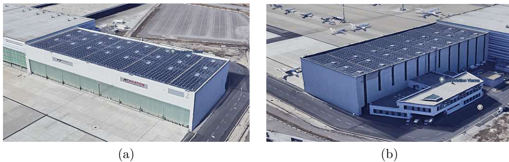
Abb. 1.1: Luftbild des Hangar 7 am Flughafen Wien: (a) Vorderseite mit den Hangartoren (übernommen aus Google Maps [27]), (b) Rückseite mit dem zugehörigen Bürogebäude (übernommen aus Google Maps [28])
