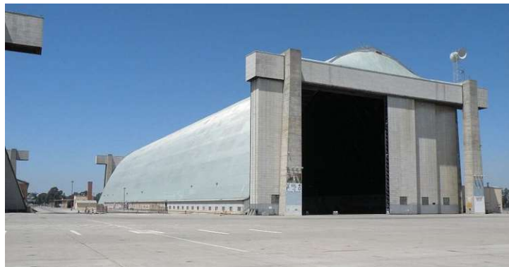
Abb. 2.5: Luftschiffhangar am Moffett Federal Airfield, Kalifornien (übernommen aus W. Anthony et al. [70])
