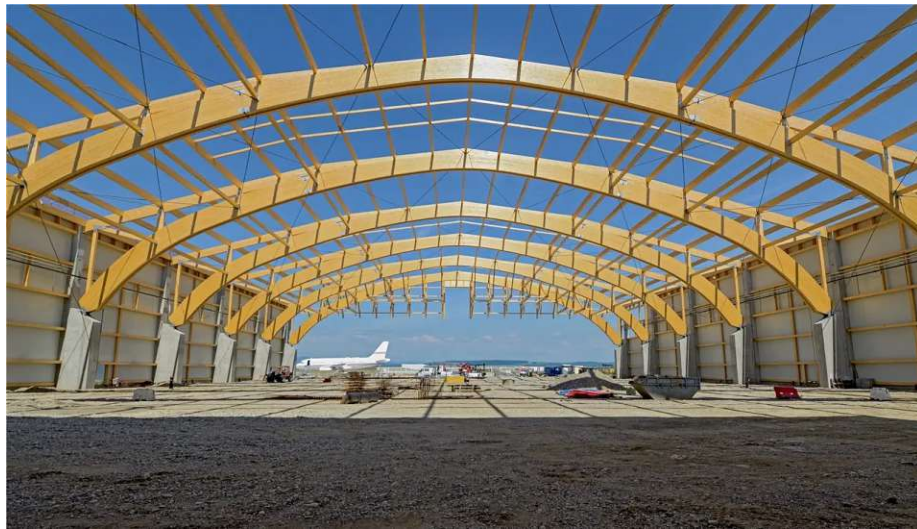
Abb. 2.13: Bogentragwerk von Hangar 4 der Firma AMAC Aerospace (übernommen aus [62])
