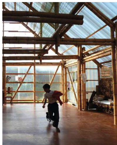
fig.240 guadua structure, Casa de la Lluvia
