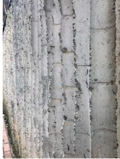
fig.100 concrete, Colegio de las Aguas
