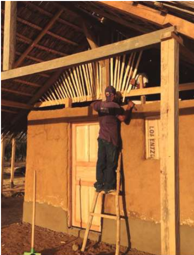
fig.197 earth wall, Dario Angulo
