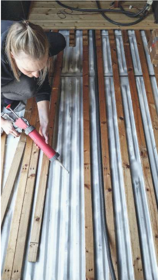
Abb.118: Die Holz-Unterkonstruktion wird an die Stahl-Bodenplatte angebracht.
