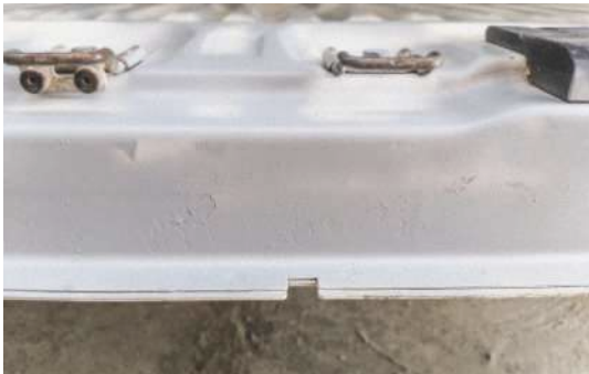
Abb.50: Grundierung und Lackierung der entrosteten Stellen.
