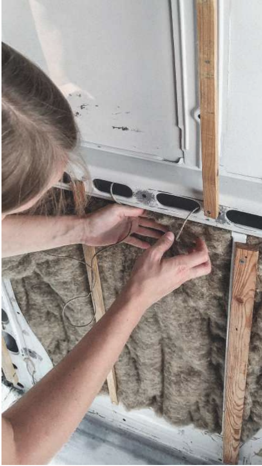
Abb.132: Anbringung des Schafwoll-Klemmfelzes und Befestigung mit Hanfkordel.
