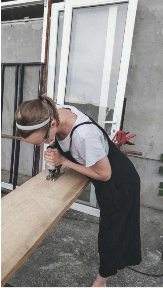
Abb.121: Vorbereitung des Holzrahmens für das Seitenfenster.
