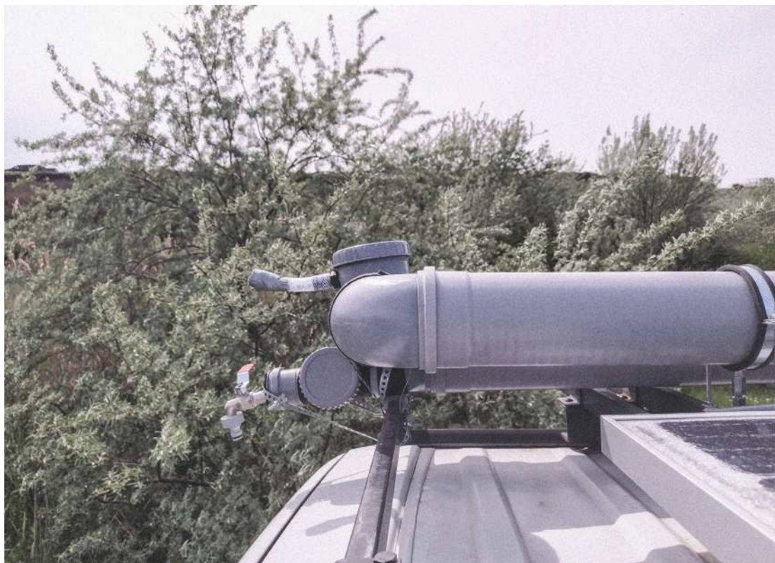
Abb.84: Sommerdusche - Anschluss für Dusche und Befüllung, sowie Entlüftungsöffnung
