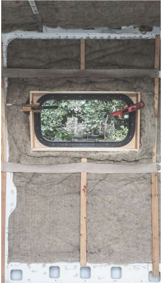
Abb.119: Das frisch eingebaute Seitenfenster wird mit Montagekleber an der Wand befestigt und sorgfältig abgedichtet.
