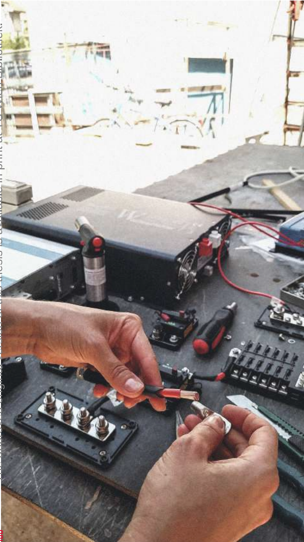
Abb.79: Anbringung der Kabelschuhe an Litzenkabel zur zuverlässigen Verbindung der Komponenten.
