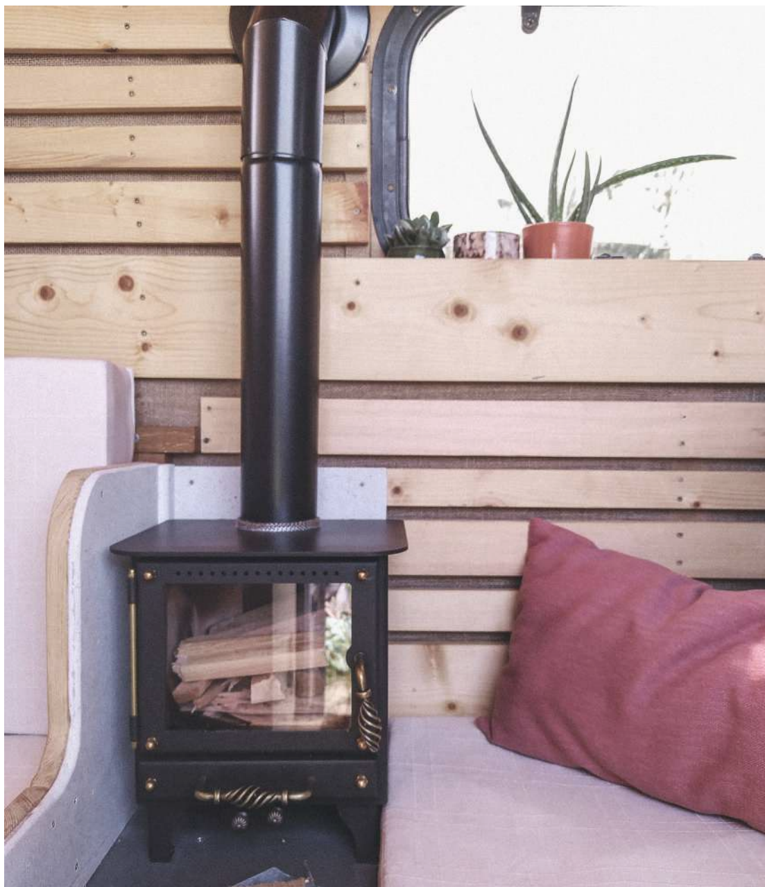
Abb.167. Holzofen mit 3 kW Leistung für warme und trockene Raumluft in kalten Jahreszeiten.
