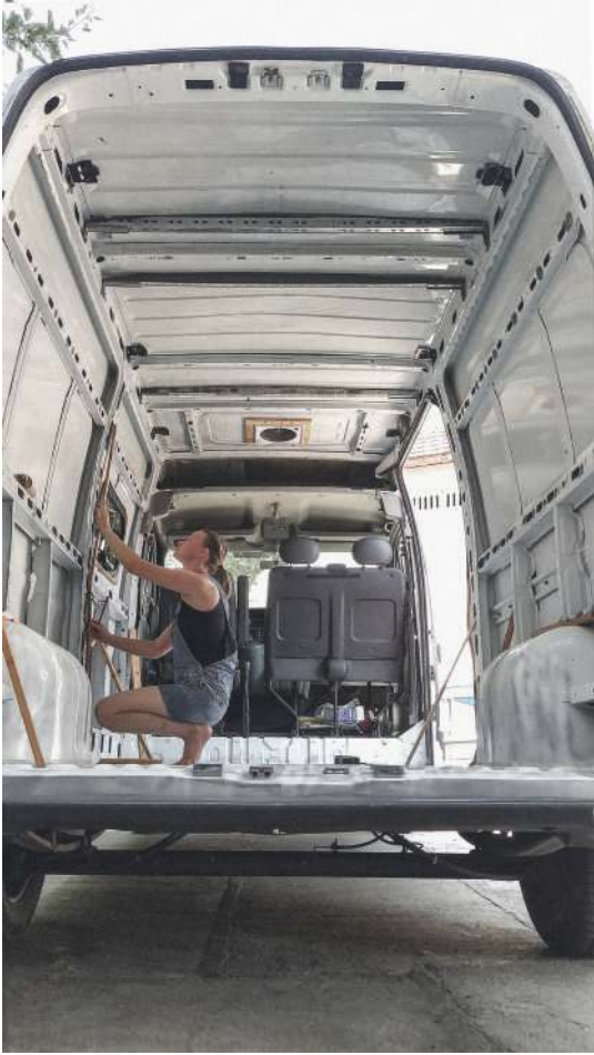
Abb.120: Montage der Unterkonstruktion an den Wänden.
