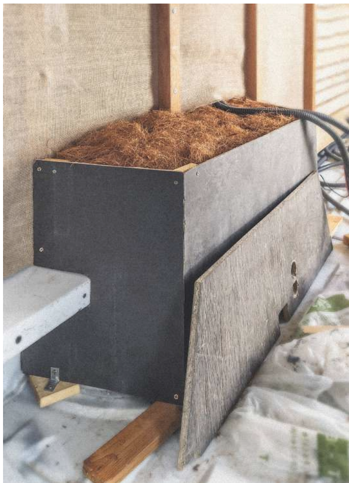
Abb.128: Verwendung von Kokosfasern zur Dämmung der Radkästen.
