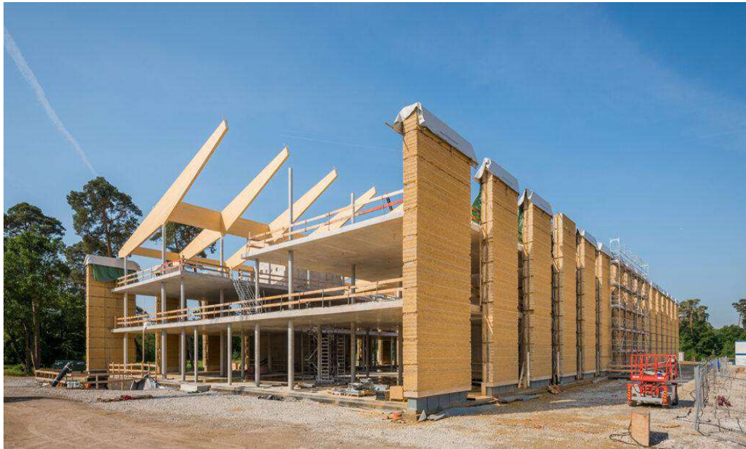
Abbildung 3: Stampflehm-Fassade des Alnatura-Campus im Bau [15]
