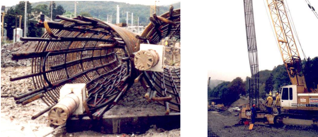
Abb. 3.5: links: Bewehrungskörbe mit Absorberleitungen; rechts: Stoß der Bewehrungskörbe
