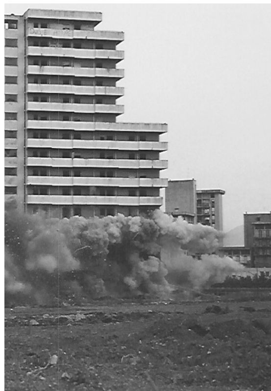
Figure 6.39: Demolition, Vele di Scampia
