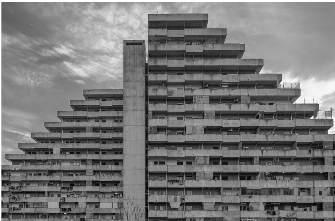
Figure 6.32: Longitudinal view, Vele di Scampia
