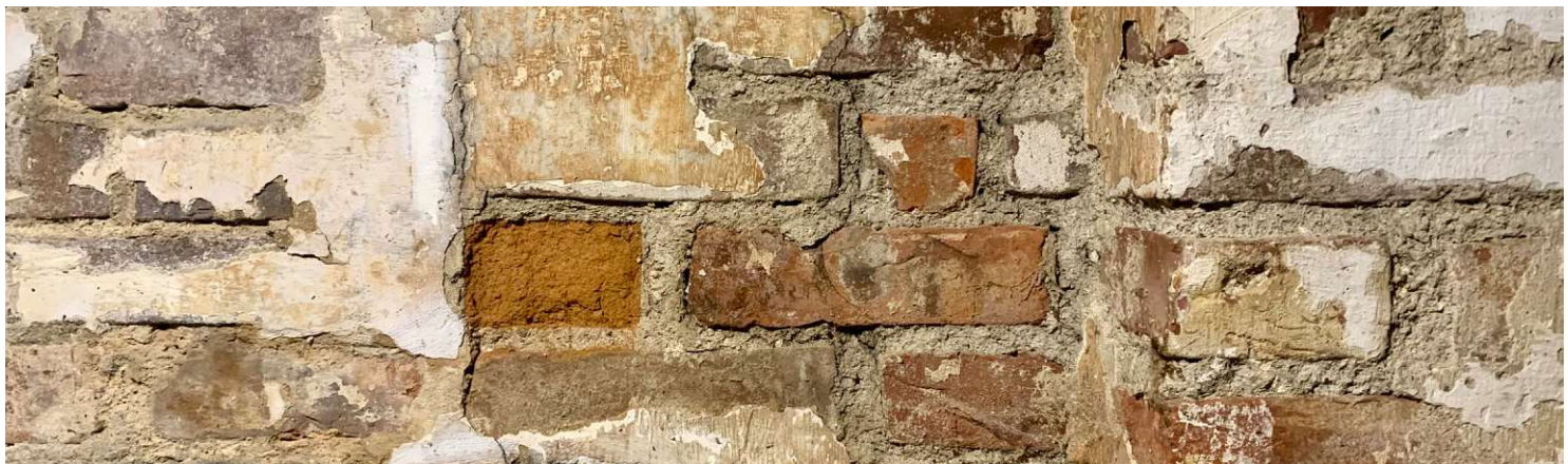
Abb. 1.17: Nahaufnahme vom Mauerwerk in meinem Keller.
