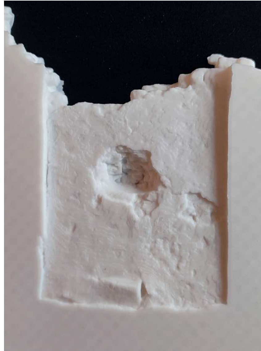
Abb.115: Schnitt durch die Kammer YKK-5, Wandansicht mit Putzstruktur
