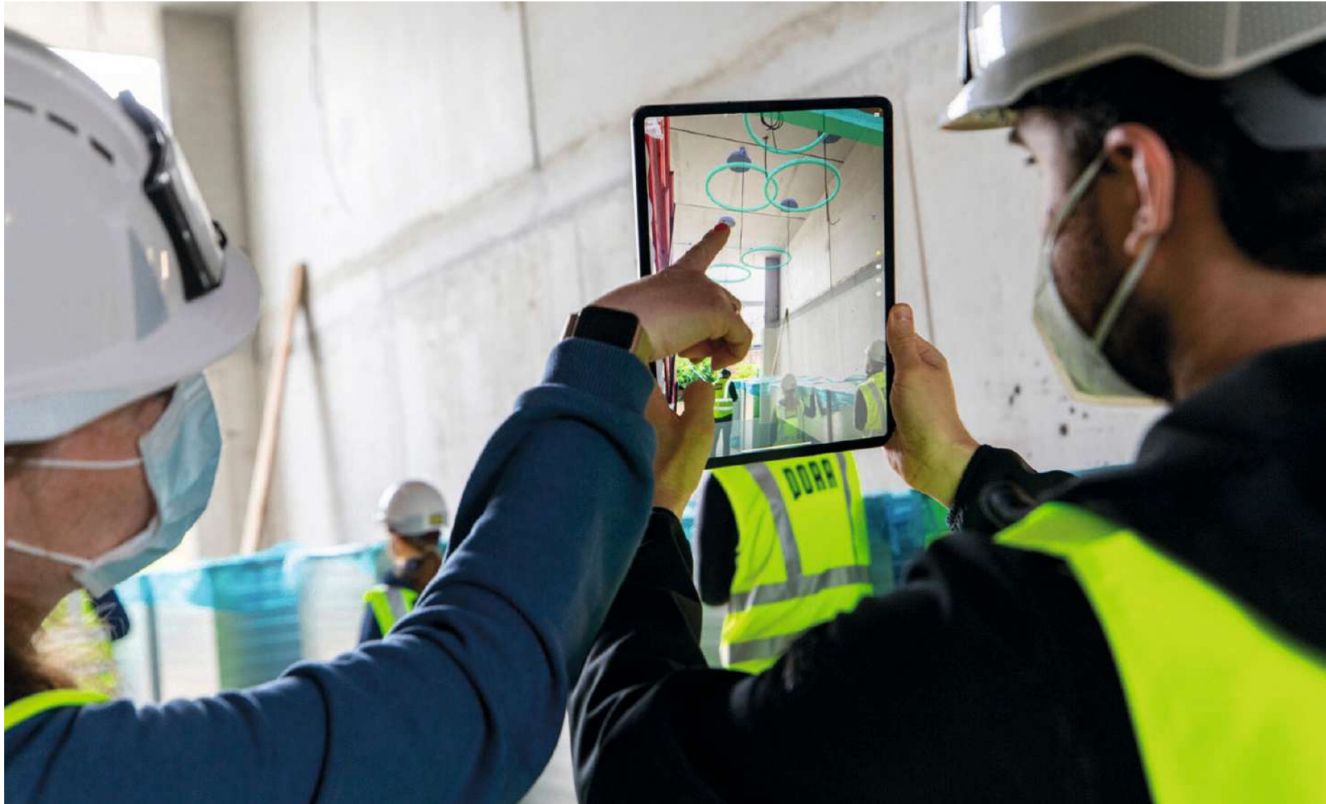
Abb.21: Überprüfung der Leitungsführung für spätere Installationen mittels Augmented Reality und der App Gamma AR | Porr AG
