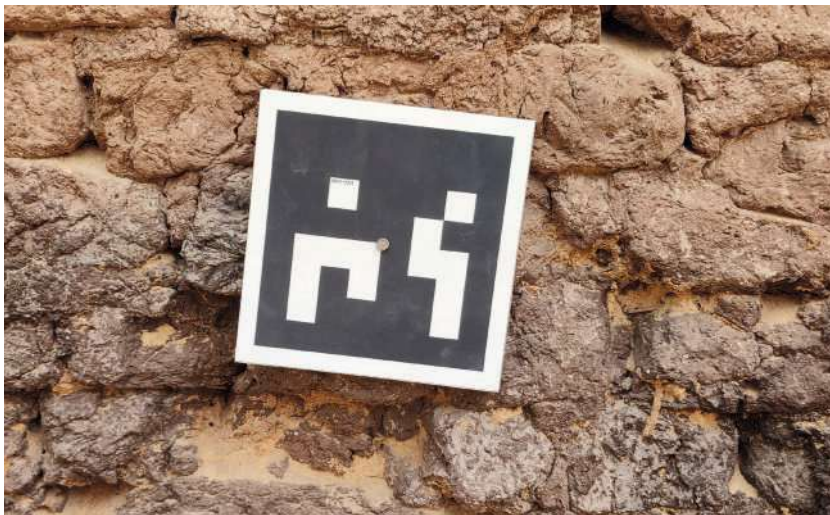
Abb.79: 36h11 AprilTag an den seitlichen Mauern der Hauptkammer
